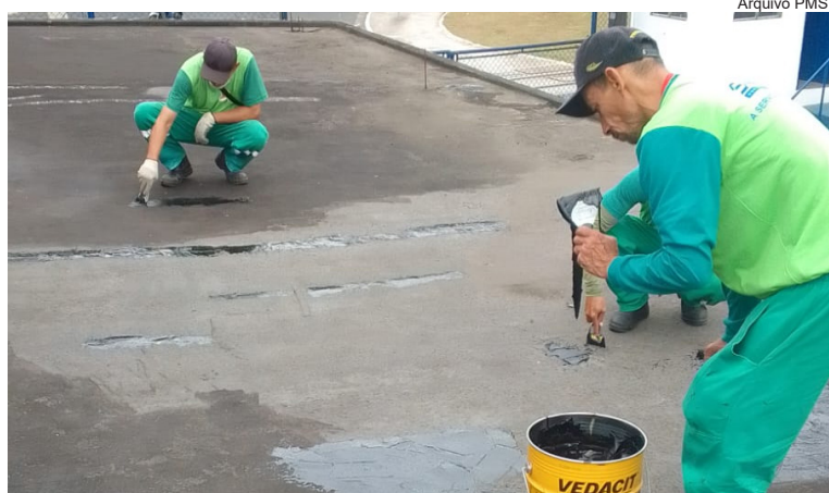
Impermeabilização da laje do setor administrativo da Prefeitura Regional
