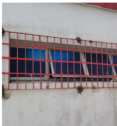
Grade de proteção do Posto 3 ganhou serviço de chumbamento
