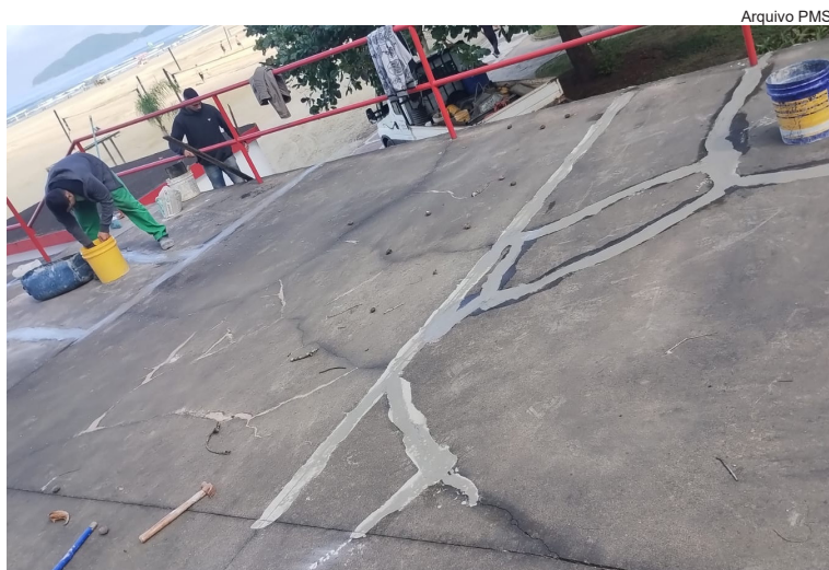
Reparos com massa para impermeabilização na laje do Posto 3 do Gonzaga
