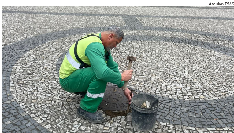
Concluídos reparos do piso mosaico da Praça Mauá
