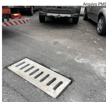
Troca de grelha de bocas de lobo no Largo Teresa Cristina, no Centro
