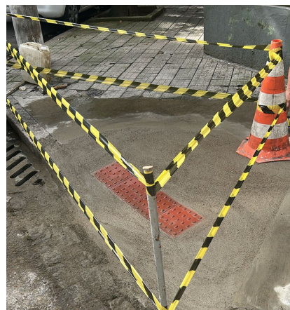
Rampa de acessibilidade no trecho Samuel Baccarat x Itapura de Miranda, no Boqueirão
