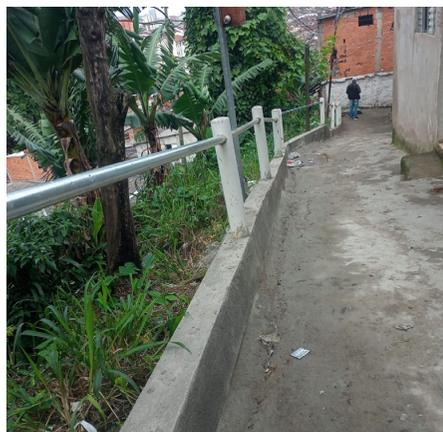
**Construção de mureta para contenção de águas pluviais, instalação de corrimão e concretagem do piso na Rua da Paz, Tetéu**
