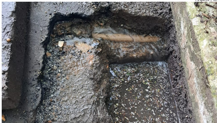
Reparos em tubulação e conserto de vazamento no Jardim Botânico
