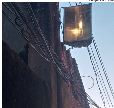
Manutenção do refletor na Rua Principal, no José Menino
