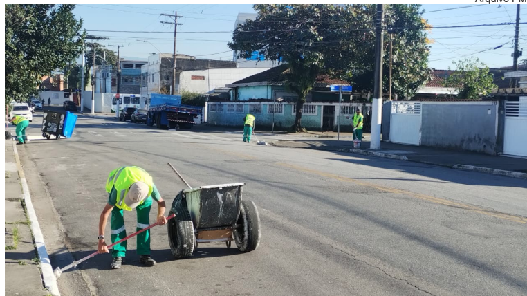
Iniciada pintura dos postes e guias na Rua Vereador Alvaro Guimarães, Rádio Clube
