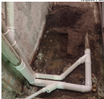
Reparo de tubulação e manutenção da torneira do Centro da Juventude
