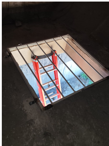
Colocação de grade sob o viaduto que liga a Avenida Martins Fontes à Avenida Nossa Senhora de Fátima
