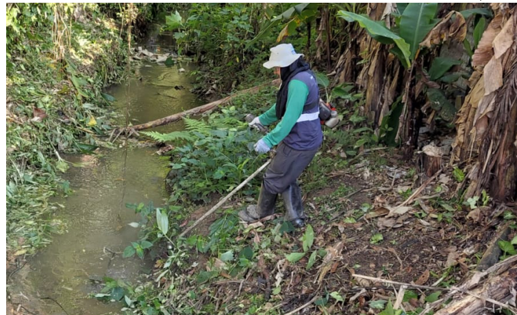
Serviço de roçada no valão da Rua Caramuru, Caruara
