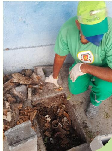
**Troca de tampa de concreto de caixa de passagem na Av. Pinheiro Machado, em frente à UME Olavo Bilac**
