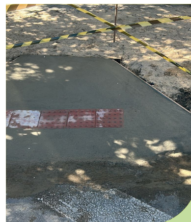
Instalação de rampa de acessibilidade na Rua Ana Pimentel, na Ponta da Praia
