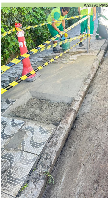
Abertura de berço para árvore na Rua Pérsio de Queiroz Filho, Encruzilhada
