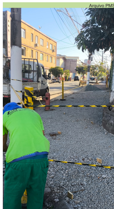
Colocação de brita para concretagem da Rua Baptista Pereira, no Macuco
