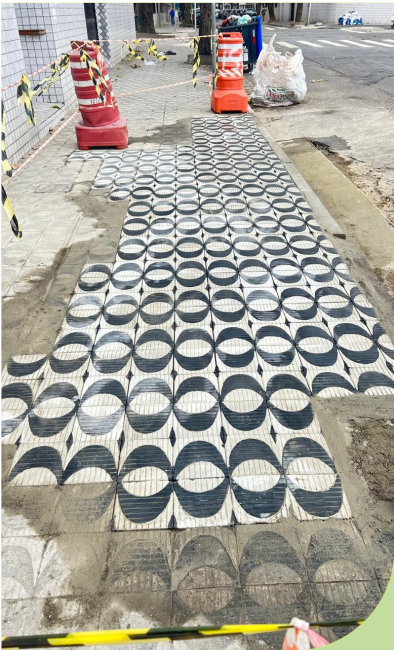
Reparo em calçada e abertura de berço na Rua Guedes Coelho, 47, Encruzilhada
