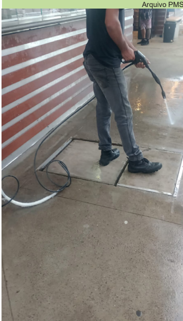
Troca de tampa de concreto em um dos quiosques na Praia, no Canal 3
