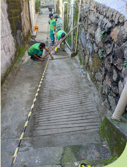
Recapeamento de trecho da Rua José Fernando Cruz, no Morro Jabaquara
