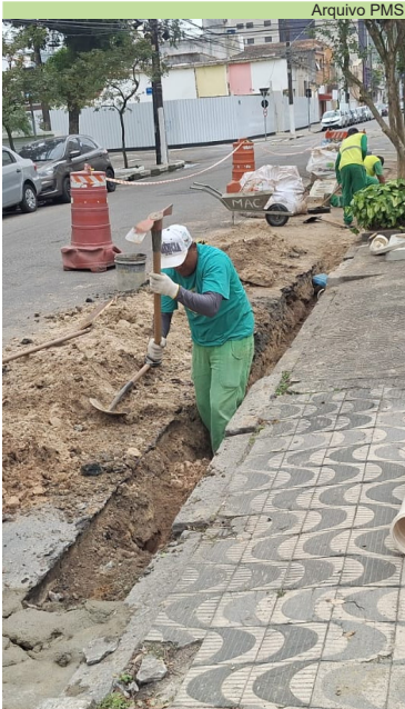
Serviço de drenagem em andamento na Rua Monsenhor de Paula Rodrigues
