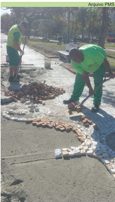
Reparo do calçamento da Orla da Praia, na Av Bartolomeu de Gusmão (Canal 5)
