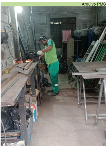
Corte de tubos para confecção do alambrado, Caneleira
