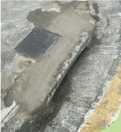
Recuperação de boca de lobo na esquina das ruas Lacerda Franco com Alfaia Rodrigues, na Aparecida
