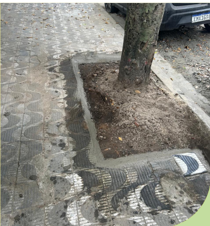
Abertura de berço e troca de boca de lobo na Rua Liberdade, em frente aos números 373 e 342
