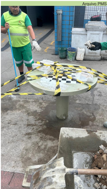
Instalação de mesa de concreto em frente ao no Ferry Boat
