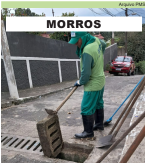
MORROS Limpeza de caixas e grelhas na R. Santa Clara, São Bento
