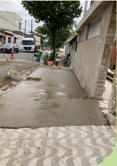
Concretagem de calçada, após retirada de árvore na Rua Dr. Benedito Evangelista, em frente ao número 104, São Jorge
