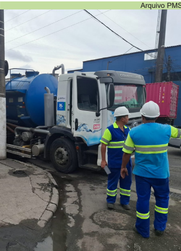
Limpeza no sistema de esgoto na N.Sra de Fátima, a Rua Ana Santos
