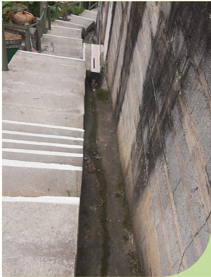
Limpeza de canaleta na Rua Santa Inês, Morro São Bento
