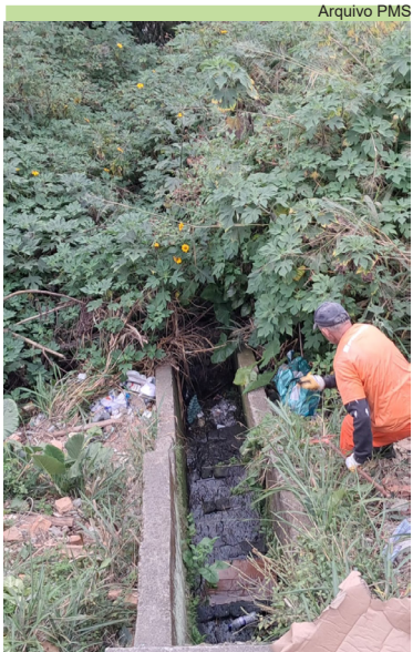
Limpeza de grelhas e escada hidráulica no Morro São Bento
