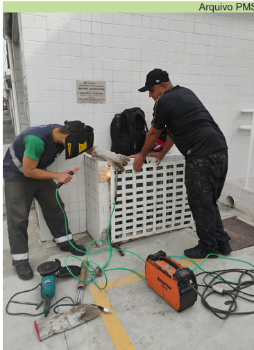
Instalação de grade de proteção no hidrômetro da Poli S.Jorge/Sta Maria
