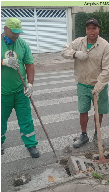
Troca de boca de lobo na Rua Vergueiro Steidel com Rua Pirajá da Silva, Aparecida
