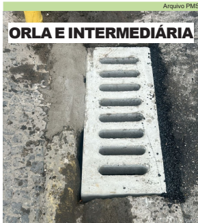
ORLA E INTERMEDIÁRIA Troca de boca de lobo na Rua Jorge Tibiriçá, no Gonzaga
