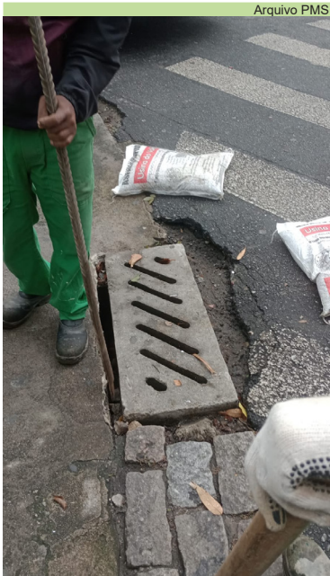
Reparo em boca de lobo na esquina das ruas Rua Cesário Mota com Osvaldo Cruz
