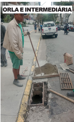
ORLA E INTERMEDIÁRIA Troca de boca de lobo na Rua Pernambuco, no Gonzaga
