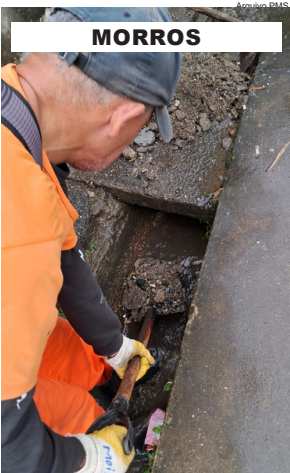
MORROS Limpeza de córrego na Rua Rubião Júnior, no Monte Serrat
