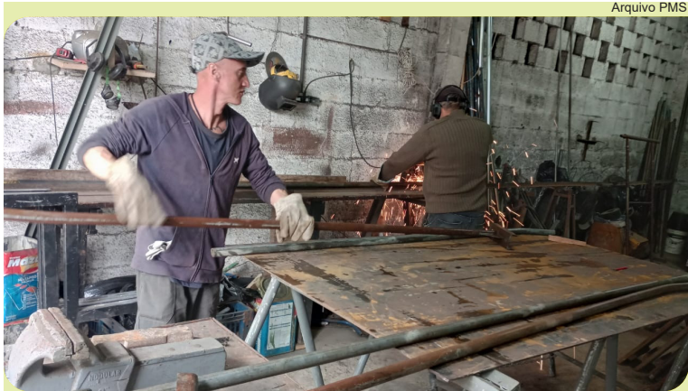
Soldagem de suportes para montagem de arquibancada
