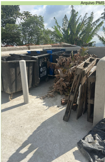
Reboco na recuperação da lixeira e muretas na Vila Progresso
