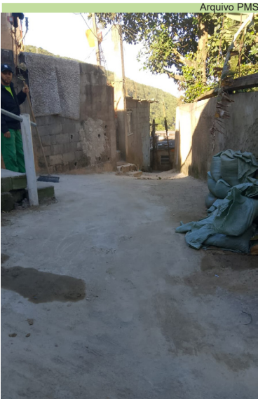
Concretagem de trecho da Rua 1 com a Rua 3, no Morro Santa Maria
