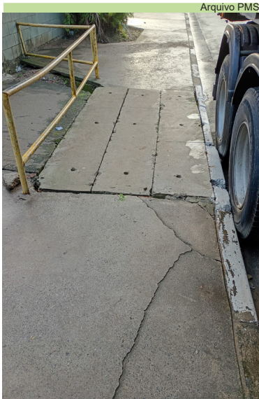
Reposição de tampas na Avenida Santista, no Nova Cintra
