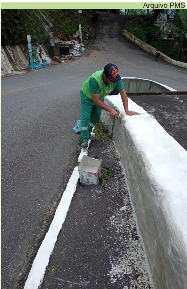
Serviço de pintura e manutenção da descida do Morro Fontana
