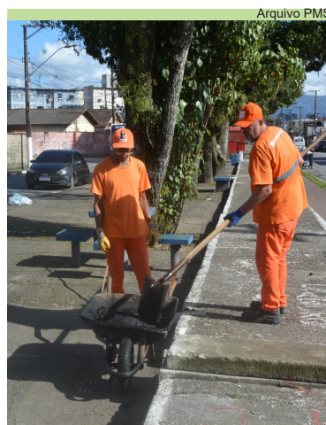
Limpeza de bueiros na Avenida Afonso Schmidt, no Castelo
