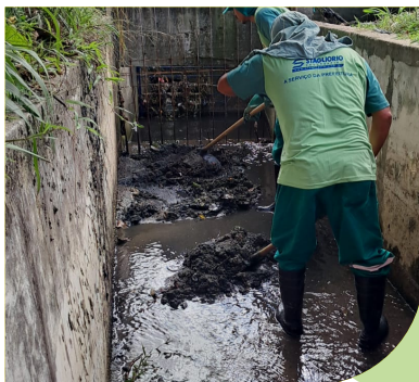
Limpeza de caixas e escada hidráulica no Complexo Marina Magalhães, no Morro São Bento
