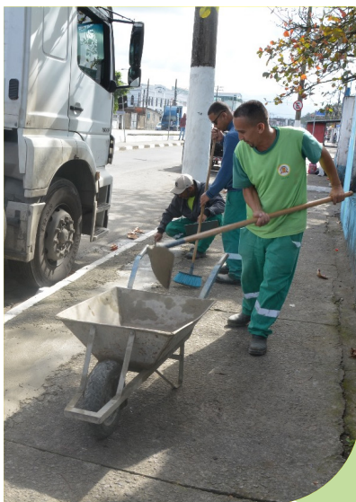
Reparo na calçada na Praça Maria da Conceição Alves, no Rádio Clube
