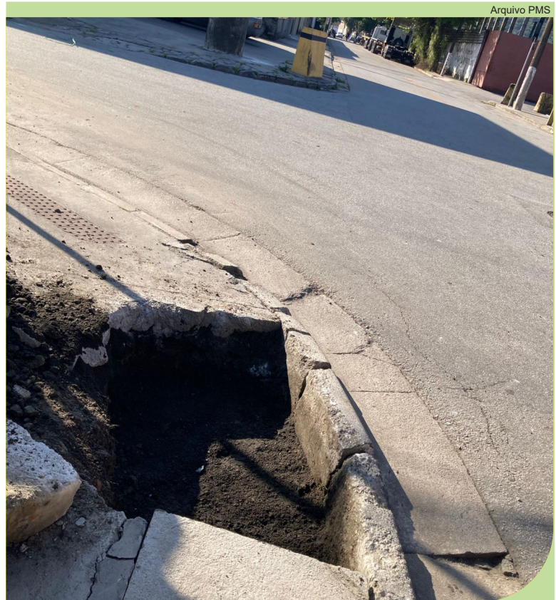
Instalação de tampa de concreto em poço de visita na esquina das ruas Ilhabela x Rua Manoel Barbosa da Silveira, Chico de Paula
