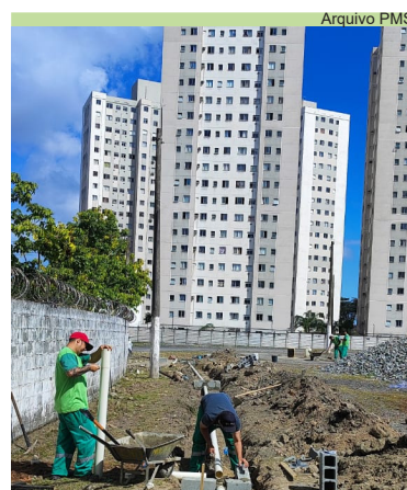
Instalação de tubos de esgoto e confecção de caixa de passagem, na Areia Branca
