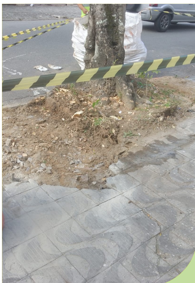
Abertura de berço e reparo de calçada na Rua Benjamin Constant, em frente ao número 171, no Embaré
