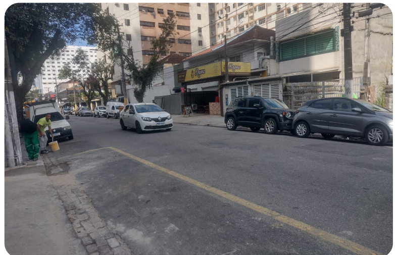
Renivelamento de sarjeta de paralelos na Rua Carlos Afonseca, em frente ao número 180
