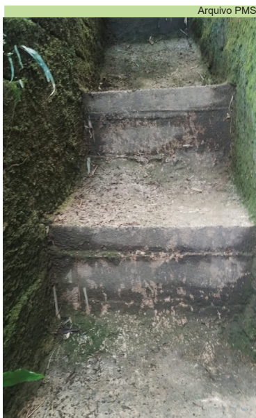
Limpeza de escada hidráulica na Rua 12, Nova Cintra
