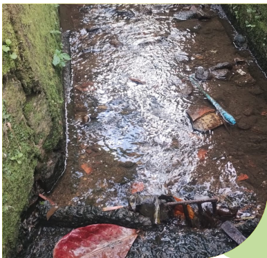
Limpeza de caixas de sopé e vala na Rua Coronel Galhardo, no Nova Cintra
