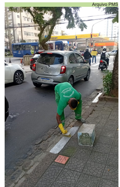
Pintura de postes e guias na Rua Doutor Luiz de Faria, no Gonzaga
