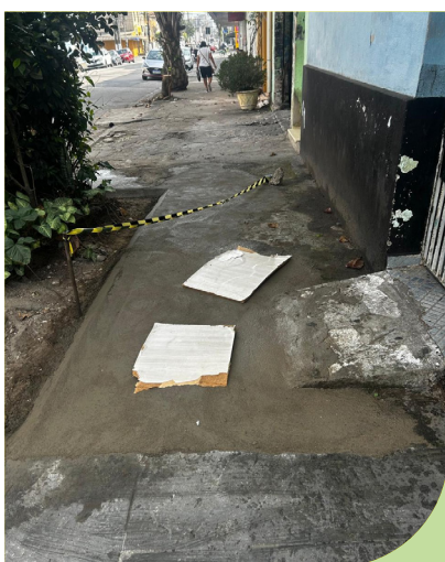
Reparo em calçada e abertura de berço na Rua Padre Anchieta, em frente ao número 222, no Macuco
