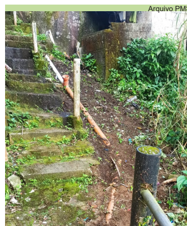
Limpeza e manutenção na Rua 8, na Vila Progresso
