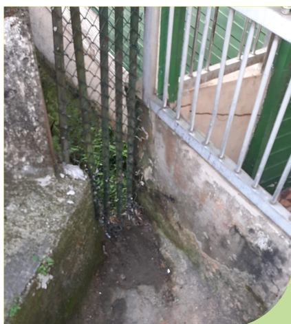
Serviço de manutenção e limpeza de córrego na Rua 5, no Morro Pacheco
