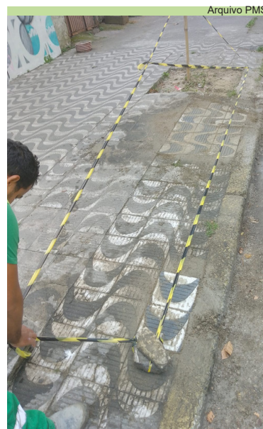
Reparo em calçada (piso copacabana) na Avenida Afonso Pena, no Estuário
