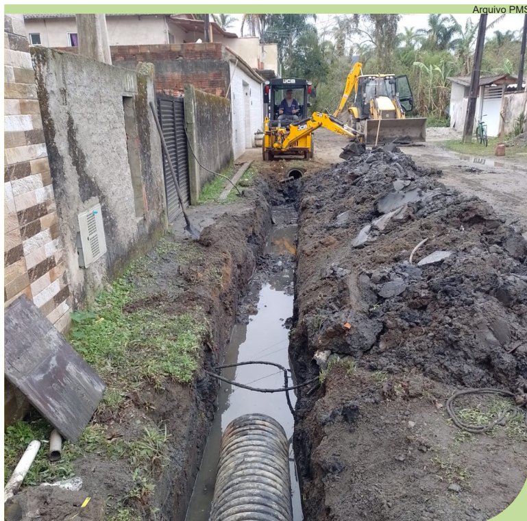
Continuação da substituição de manilhas e instalação de tubos na Rua Trusilva, no Caruara
