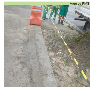
Abertura de berço em calçada de concreto na Rua Carvalho de Mendonça, 187
