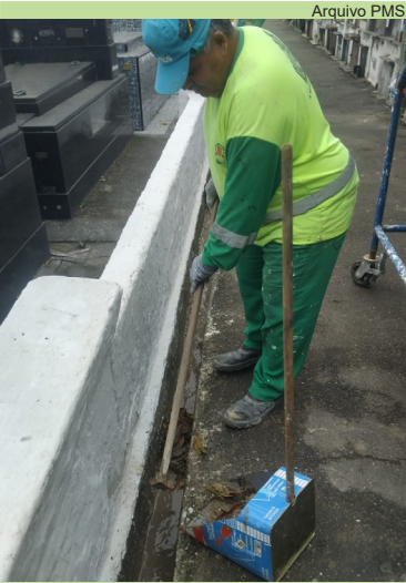
Limpeza da canaleta de drenagem no Cemitério da Filosofia
