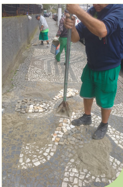
Reparo em calçada de mosaico preto e branco na Avenida Epitácio Pessoa, ao lado do posto do INSS, na Aparecida
