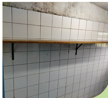
Instalação de prateleiras na Sociedade Esportiva do Caruara
