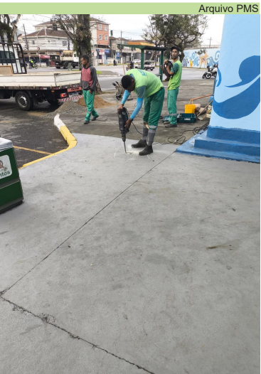
Manutenção da calçada parte externa do cemitério da Areia Branca
