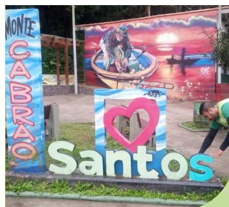
Substituição de letra vandalizada no totem do Monte Cabrão
