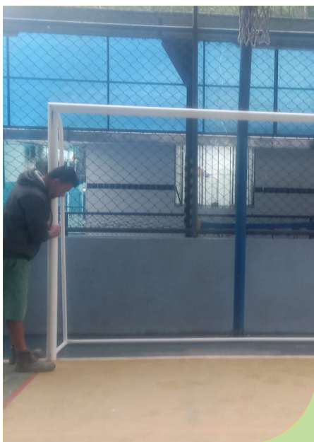
Manutenção nas traves da quadra da Unidade Municipal de Educação Monte Cabrão
