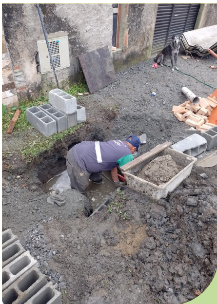
Instalação de manilhas e confecção de caixas de passagem na Rua Trusilva, no Caruara
