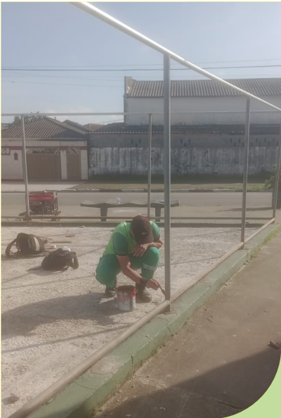
Soldagem do alambrado e acabamento no campinho de gol caixote, na Praça Giácomo Bruneto, no Rádio Clube
