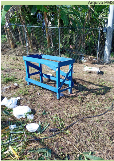
Produção de bancadas para pia, que será instalada no Monte Serrat
