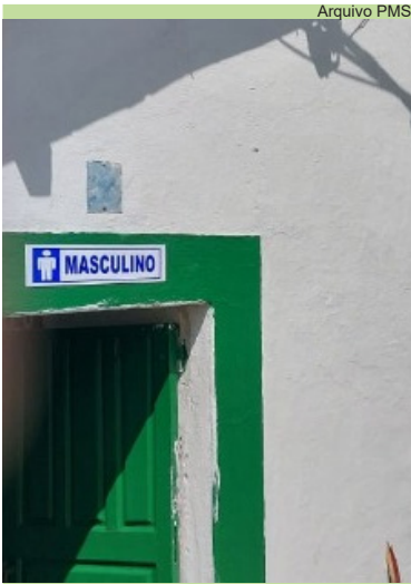
Colocação de placas de identificação de banheiros, no Monte Serrat
