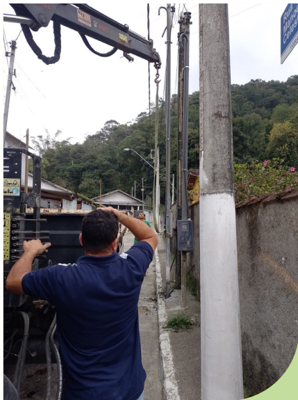
Retirada de poste na Rua Manoel Celestino, no Monte Cabrão
