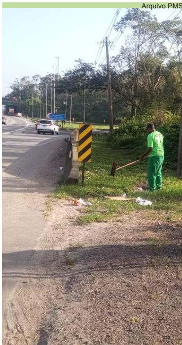
Serviço de roçada pelas ruas do Monte Cabrão
