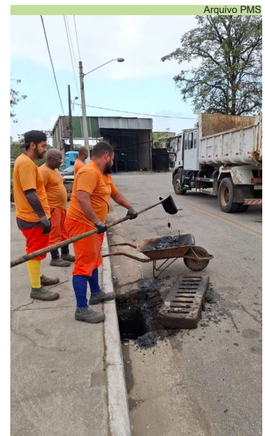
Limpeza das galerias de águas pluviais da Praça Nicolau Geraigire, no São Manoel
