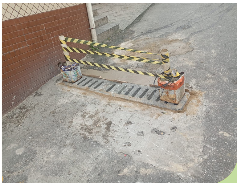
Manutenção de grelha na Rua São Marcos, em frente ao número 4732, no Morro São Bento
