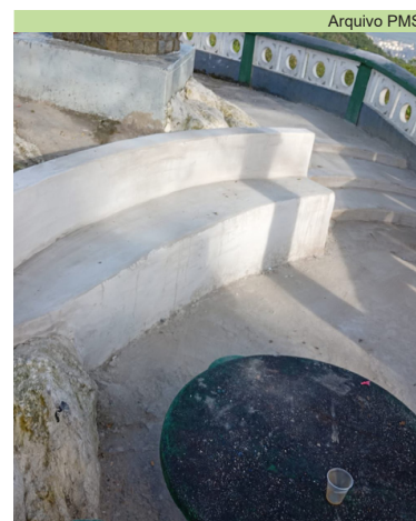
Revitalização geral de degraus na Rua 3, na Praça do Céu, Vila Progresso
