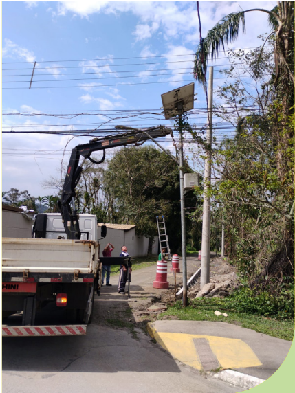
Retirada de postes de iluminação para nova rede na Rua Vila Rica, no Caruara
