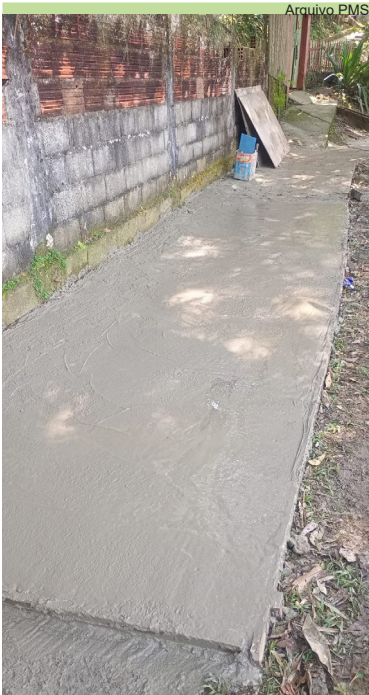
Concretagem no Caminho Manoel Ferretti, no Monte Cabrão
