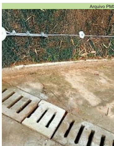
Troca de grelha na Rua Monsenhor Moreira, sem número, no Monte Serrat
