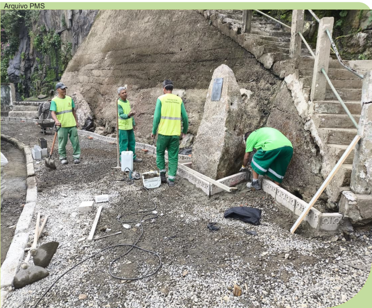
Finalização dos cordoneis e preparação para a concretagem da calçada no Quilombo do Jabaquara
