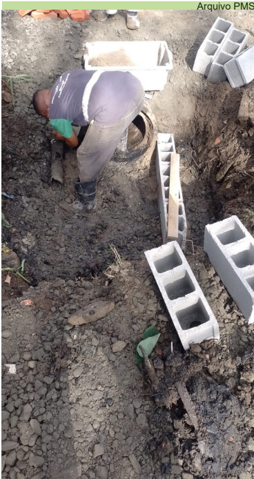
Confecção de caixa de passagem na Rua Trusilva
