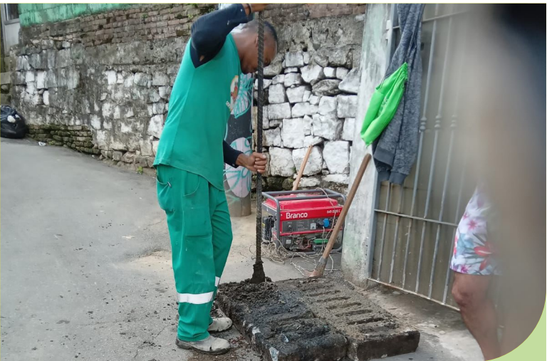
Desobstrução em grelha na Estrada João Baptista, em frente ao número 98, Morro Penha
