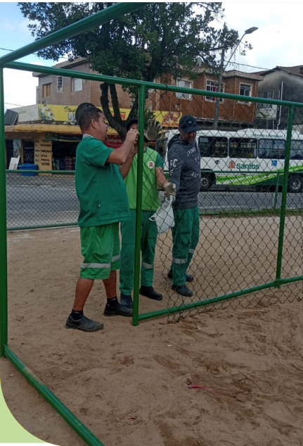
Colocação de telas, amarração e esticamento no alambrado do campinho de futebol de areia ao lado do playground na Praça Jerônimo La Terza
