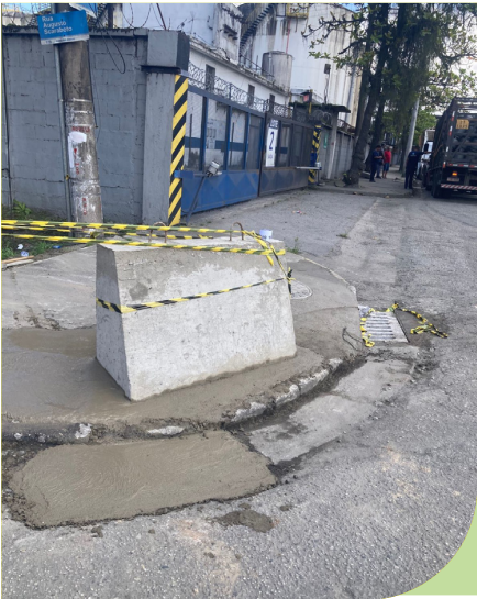
Instalação de malotão na esquina das rua Aurélio Batista Félix com Augusto Scaraboto, na Alemoa Industrial
