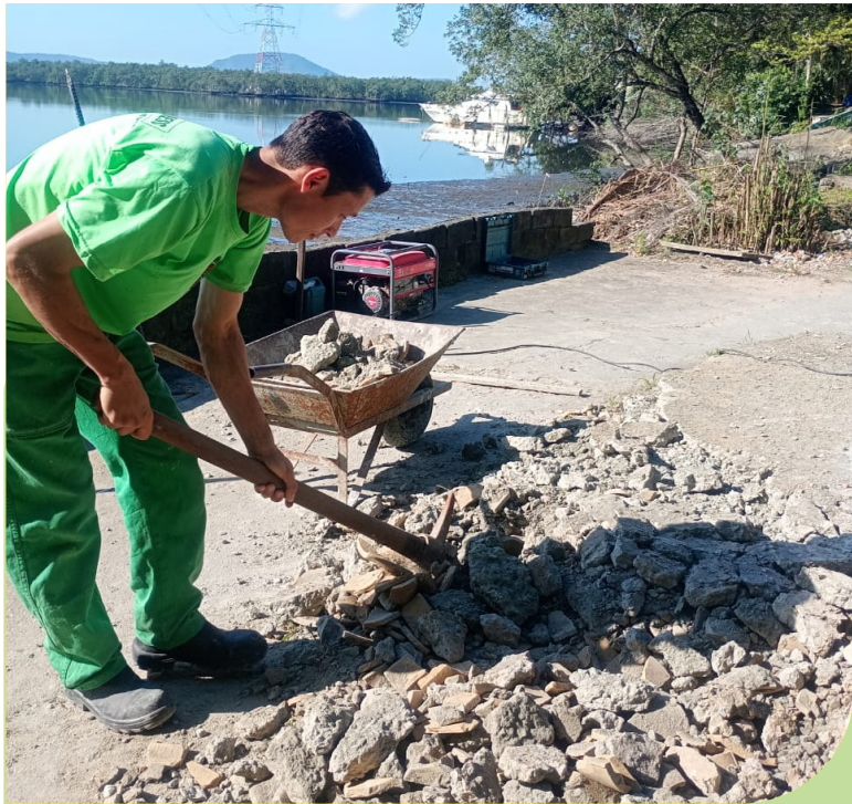
Retirada de concreto para regularizar o terreno para a concretagem do caminho Manoel Ferretti
