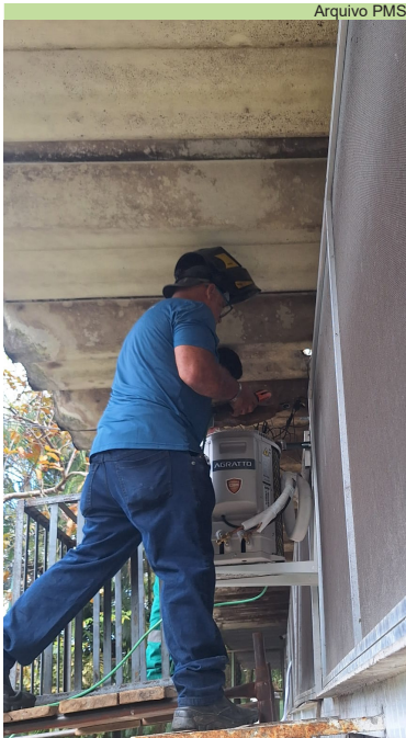
Instalação de aparelho de ar-condicionado na policlínica do Rádio Clube
