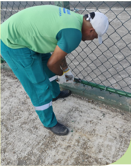
Finalização da colocação de telas, amarração e esticamento no alambrado do campinho de futebol na Pça. Giacomo Bruneto, no Rádio Clube
