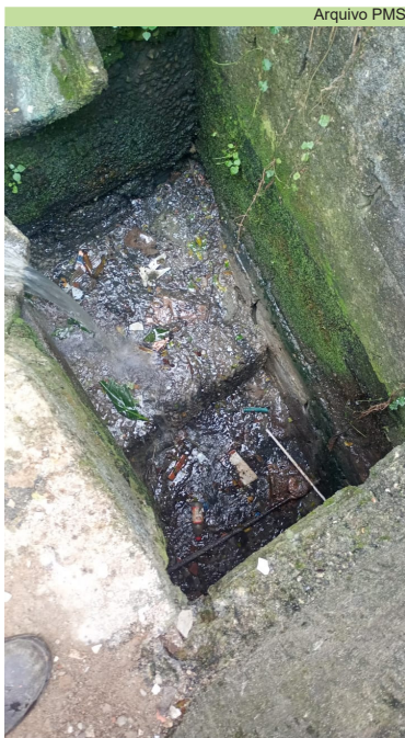
Serviço de limpeza de canaleta e caixas na Rua 6, na Vila Progresso
