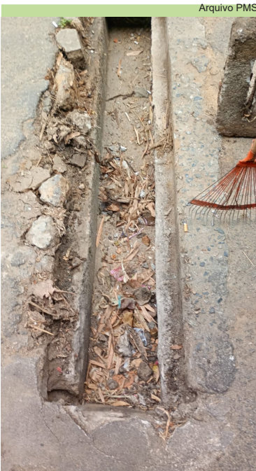
Limpeza de grelhas e canaleta Rua Vila Merengue, na Vila Progresso
