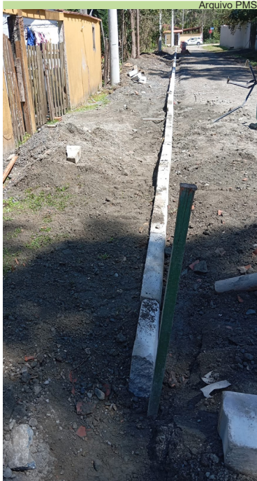
Continuação do serviço de instalação de guias na Rua Vila Rica
