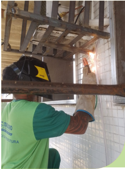
Instalação das grades de proteção nos aparelhos de ar-condicionado da Policlínica do Rádio Clube
