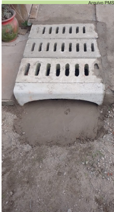
Reparo em caixa de passagem na Rua Xavantes, no Caruara
