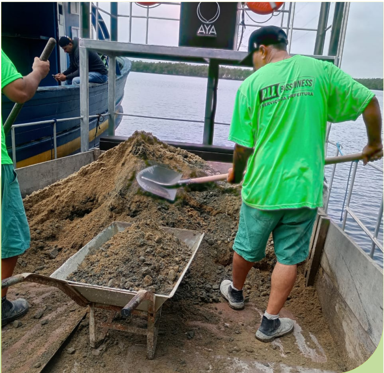
Transporte de material para concretagem no Caminho Manoel Ferretti, no Monte Cabrão
