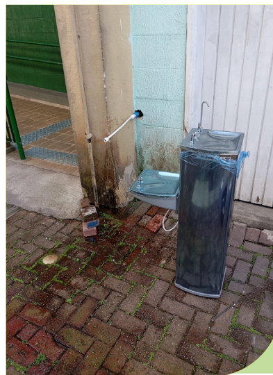
Instalação de bebedouro elétrico na quadra do Ginásio Dale Coutinho, no Castelo
