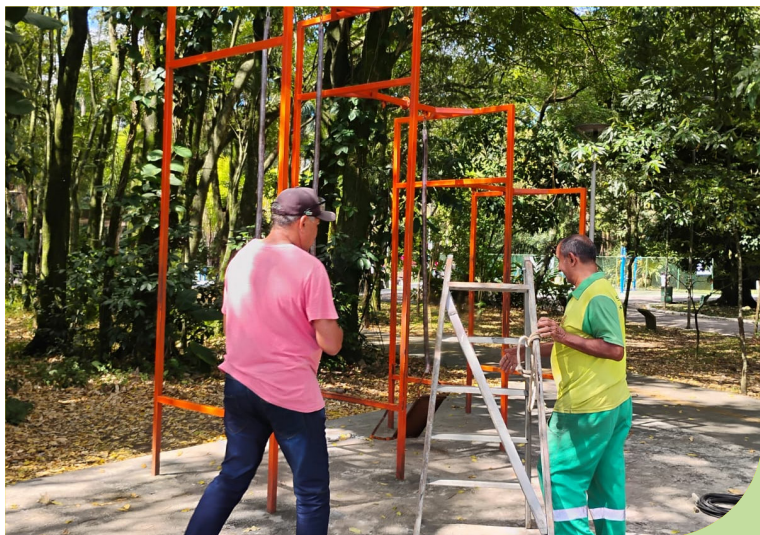
Remoção de balanços danificados no Jardim Botânico, no Bom Retiro
