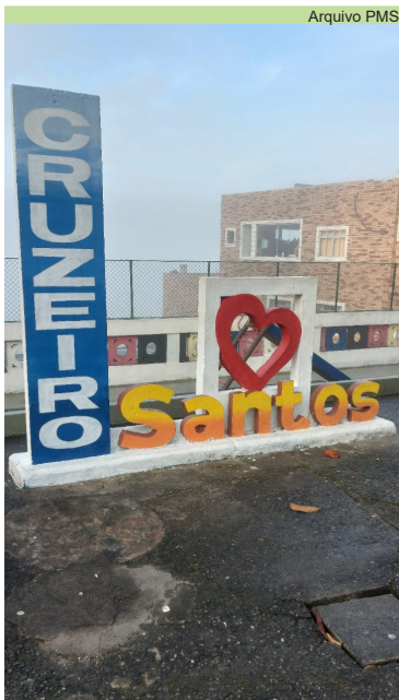
Manutenção e troca de letras danificadas do totem da Vila Cruzeiro
