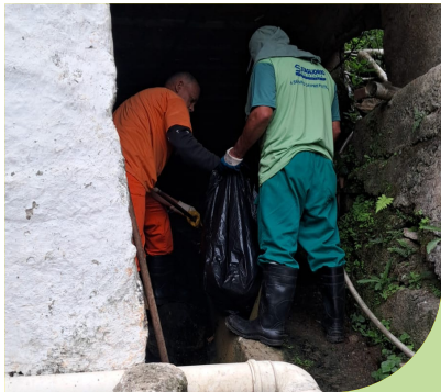
Limpeza de caixas e escada hidráulica no Nicho 3, no Monte Serrat
