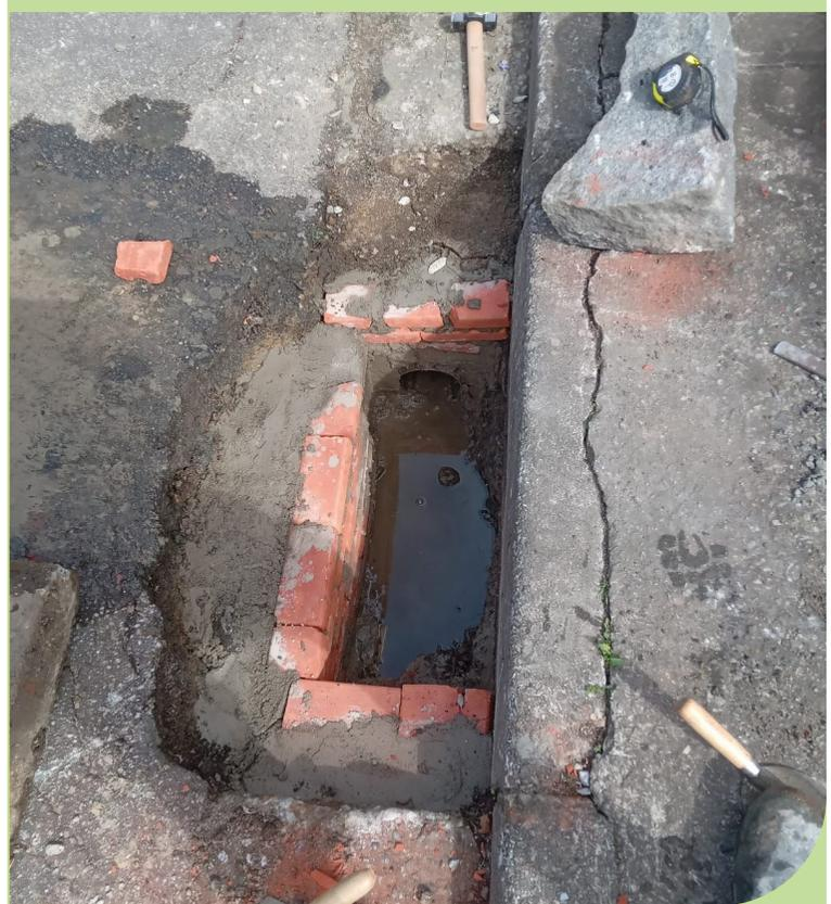
**Manutenção em caixa de passagem e nivelamento de grelhas de concreto na Rua das Orquídeas, em frente ao 357, no Morro Nova Cintra**
