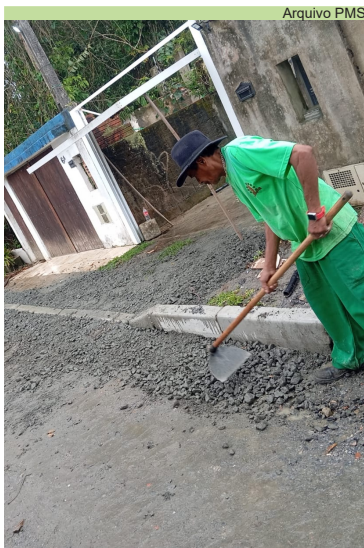
Instalação de guias na Rua Vila Rica, no Caruara
