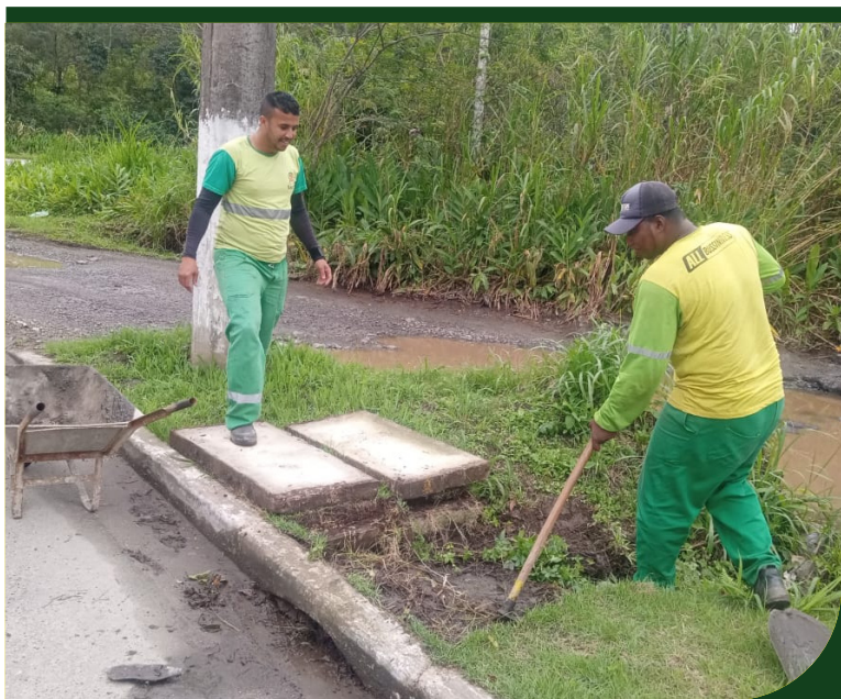
Monte Cabrão: Limpeza de caixas de drenagem da Rua Principal
