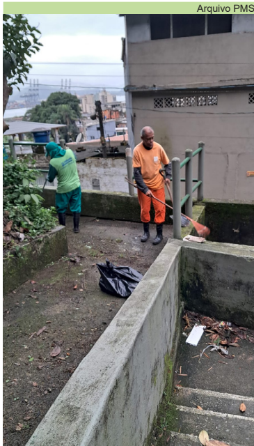
Limpeza de caixas no Recanto Raul Lúcio, no Vila São Bento
