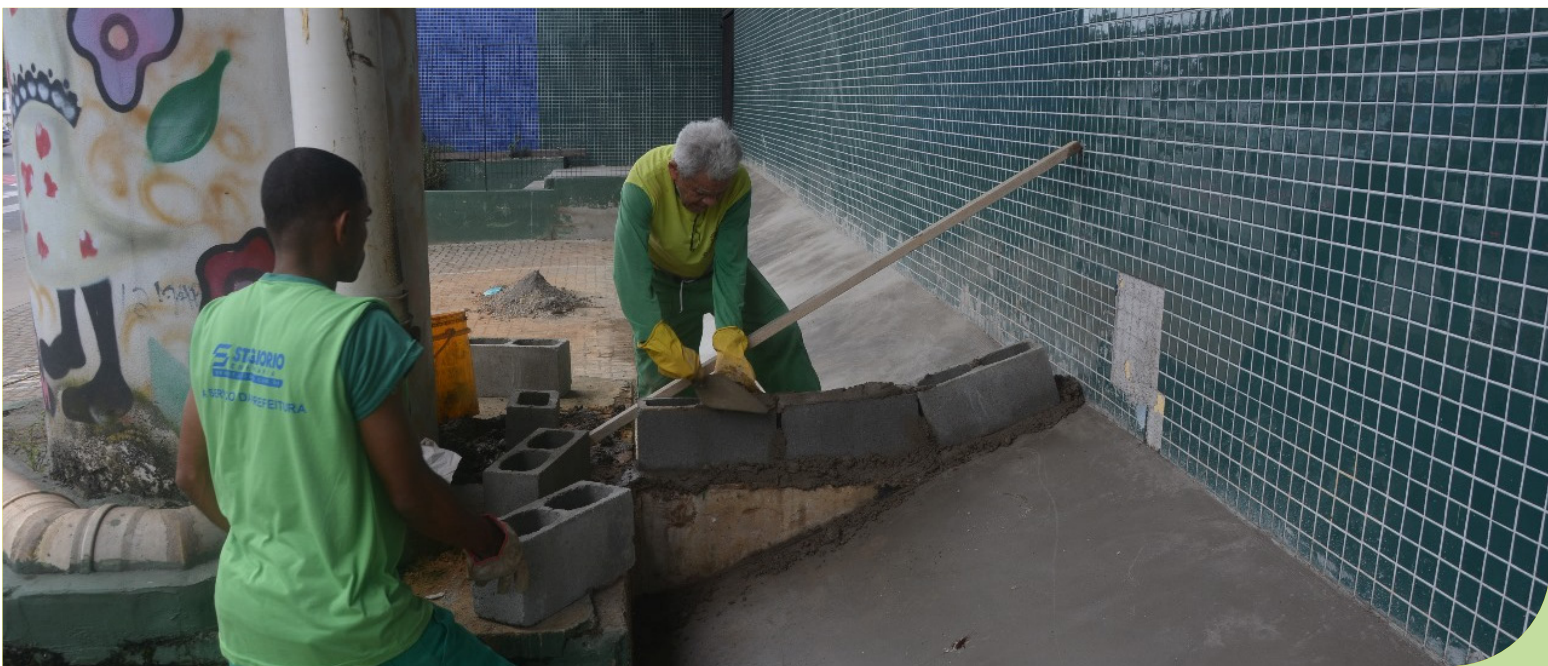
Instalação de bloqueio na parede da rampa da quadra poliesportiva do Ginásio M.Nascimento Jr
