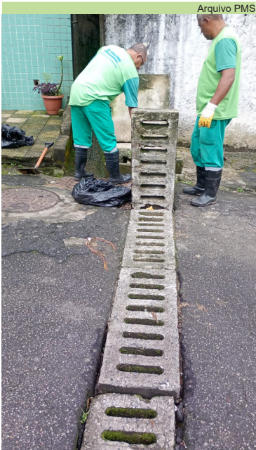
Limpeza de grelhas na Travessa 1, no Santa Maria
