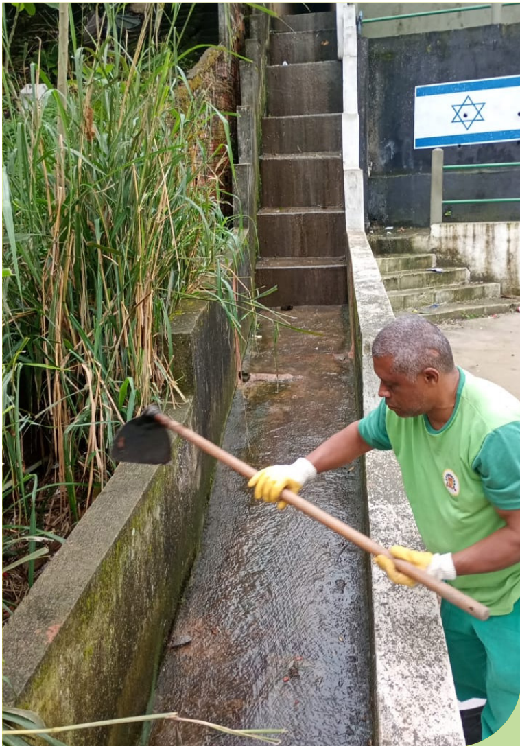
Limpeza de caixas, escada hidráulica e vala na Travessa 1, no Santa Maria
