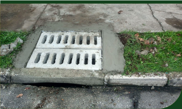
Substituição de tampas quebradas por grelhas de concreto na Avenida Torquato Dias, no Morro Nova Cintra
