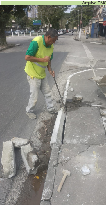
Troca de boca de sapo e reparos no entorno na Av. Francisco Manoel, no Jabaquara
