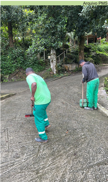
Limpeza e varrição nas ruas do Monte Cabrão
