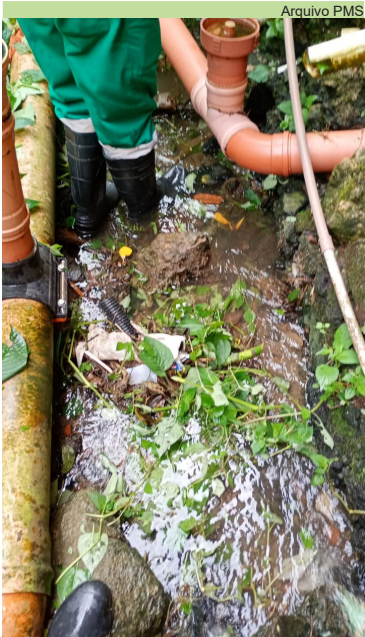
Limpeza de vala na Rua Eugênio Batista da Silva, no Nova Cintra
