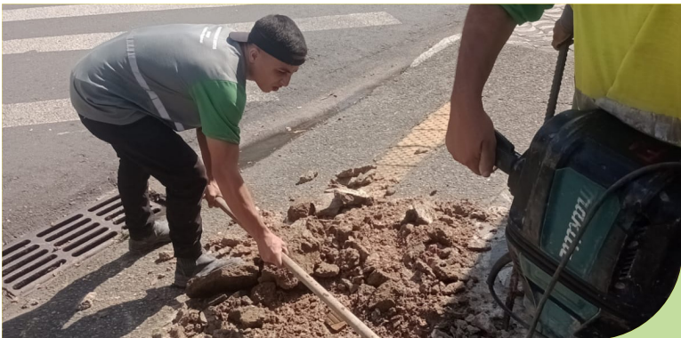
Manutenção asfáltica na Rua Augusto Paulino, 103, no Campo Grande
