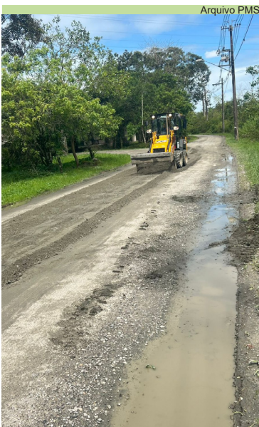
Abertura de vala e nivelamento de rua na entrada do Monte Cabrão
