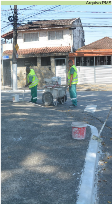
Pintura de guias e sarjetas na Rua Professor Laurindo Chaves, no Castelo
