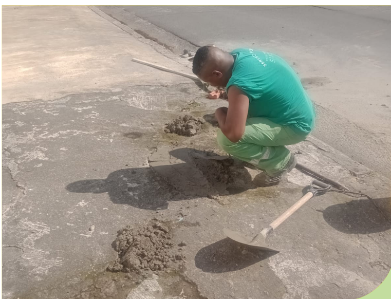
Reparo em calçada e troca de boca de lobo na Rua Barão de Ramalho
