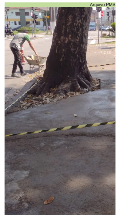
Reparo em calçada na Avenida Washington Luiz, na Vila Mathias
