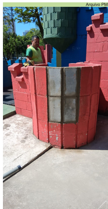
Reparo na parede do castelinho na Praça Engenheiro José Rebouças
