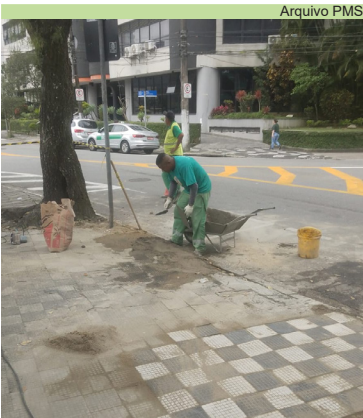
Reparo em calçada em cruzamento da Encruzilhada
