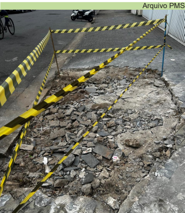
Reparo em calçada depois de remoção de árvore na Rua Santos Dumont
