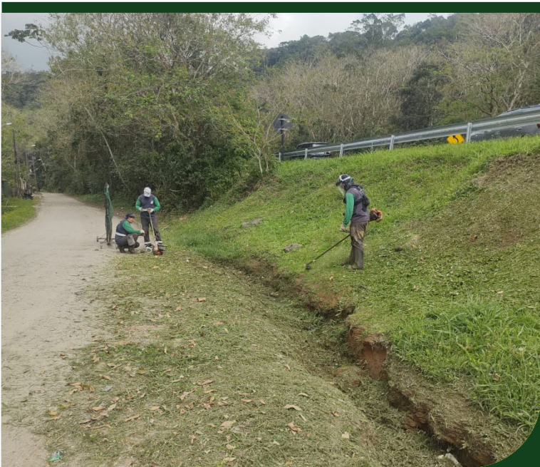
Continuação dos trabalhos de roçada na Rua Marginal, no Caruara
