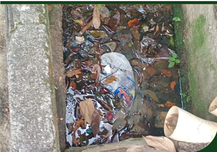
Limpeza de caixas e vala na Rua dos Inválidos, no Nova Cintra
