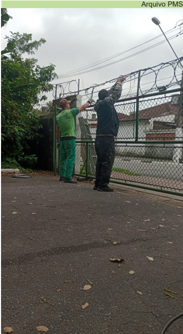
Reparos nas cercas concertinas sobre o portão e muro do Jardim Botânico
