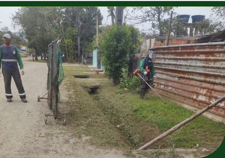
Continuação do serviço de roçada na Rua Marginal, no Caruara
