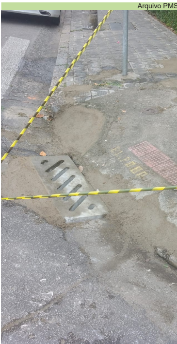
Troca de boca de lobo e reparo de calçada na esquina da Av Senador Dantas
