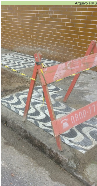
Reparo em calçada de piso Copacabana na esquina das ruas Pará e Álvaro Guião
