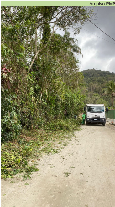
Cata-treco e retirada de vegetação no bairro do Caruara
