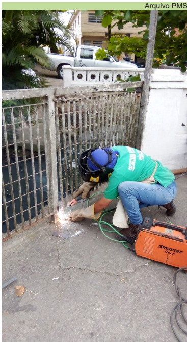
Soldagem de tubos no guarda-corpo no canal na Avenida Brig. Faria Lima
