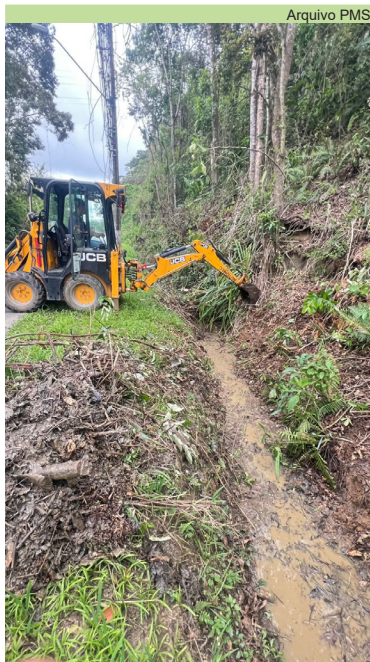
Limpeza de vala da rua Principal do Monte Cabrão
