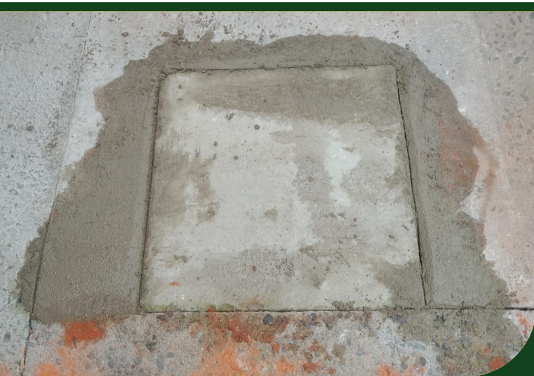
Troca de tampa de concreto na Unidade Municipal de Educação Prof. Antônio de Oliveira Passos Sobrinho, no Macuco
