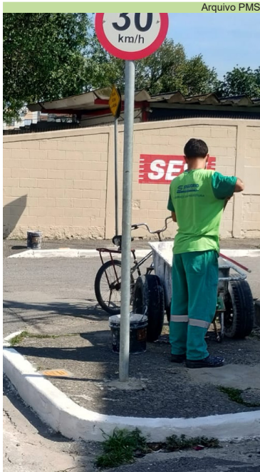
Pintura de postes e guias nas ruas Leila Diniz e Nelson Spíndola Lobato, no Rádio Clube
