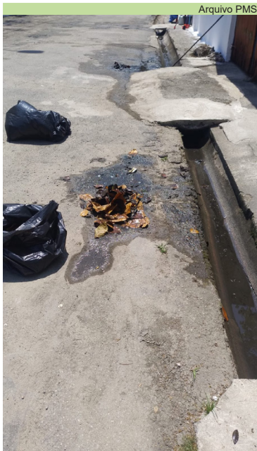
Limpeza de canaleta na Rua Dr. Nilo Peçanha, no Marapé
