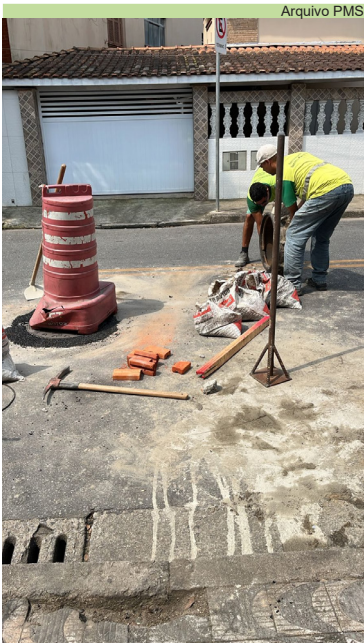
Reposição do poço de visita na Rua Comendador Martins, 530, na Encruzilhada
