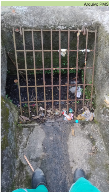
Serviço de limpeza de caixa na Rua 4, no Marapé
