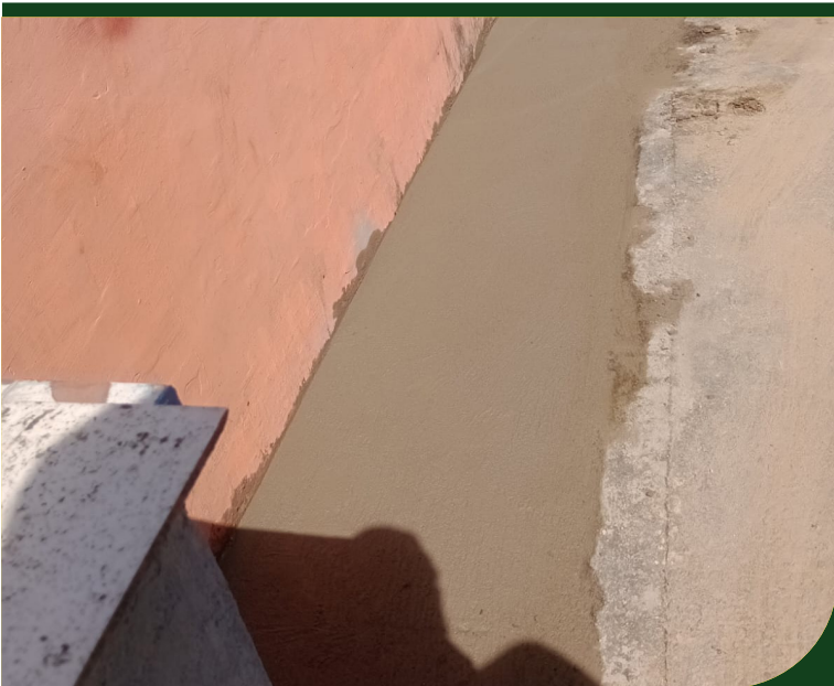
Reparos no imóvel da Defesa Civil
