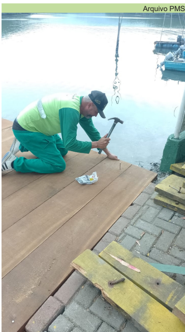
Continuação da reforma do píer de acesso à Ilha Diana
