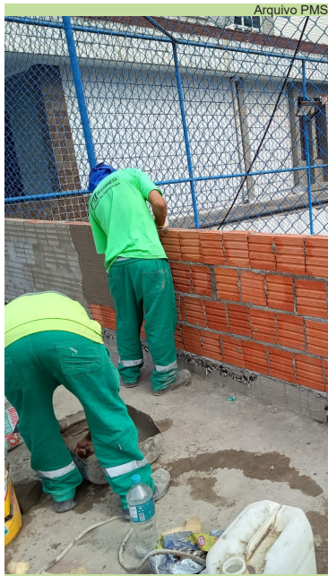
Construção de paredes para instalação do telhado em equipamento municipal
