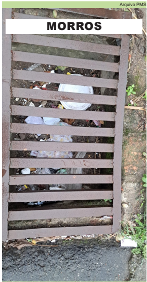
MORROS Limpeza de grelhas e canaleta na Rua F, Morro José Menino
