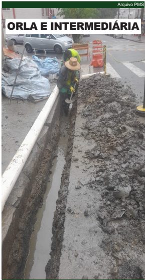
ORLA E INTERMEDIÁRIA Ampliação de rede de drenagem na Rua Gastão Vidigal
