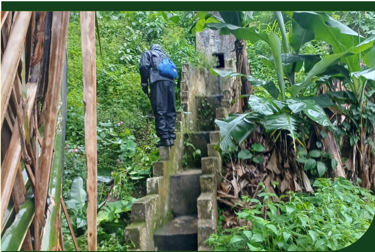
Limpeza de caixas e escada hidráulica Praça Noé de Carvalho
