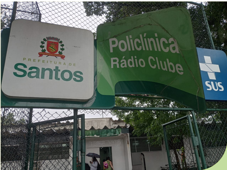
Retirada da placa de identificação na entrada da policlínica do Rádio Clube, danificada pelos fortes ventos
