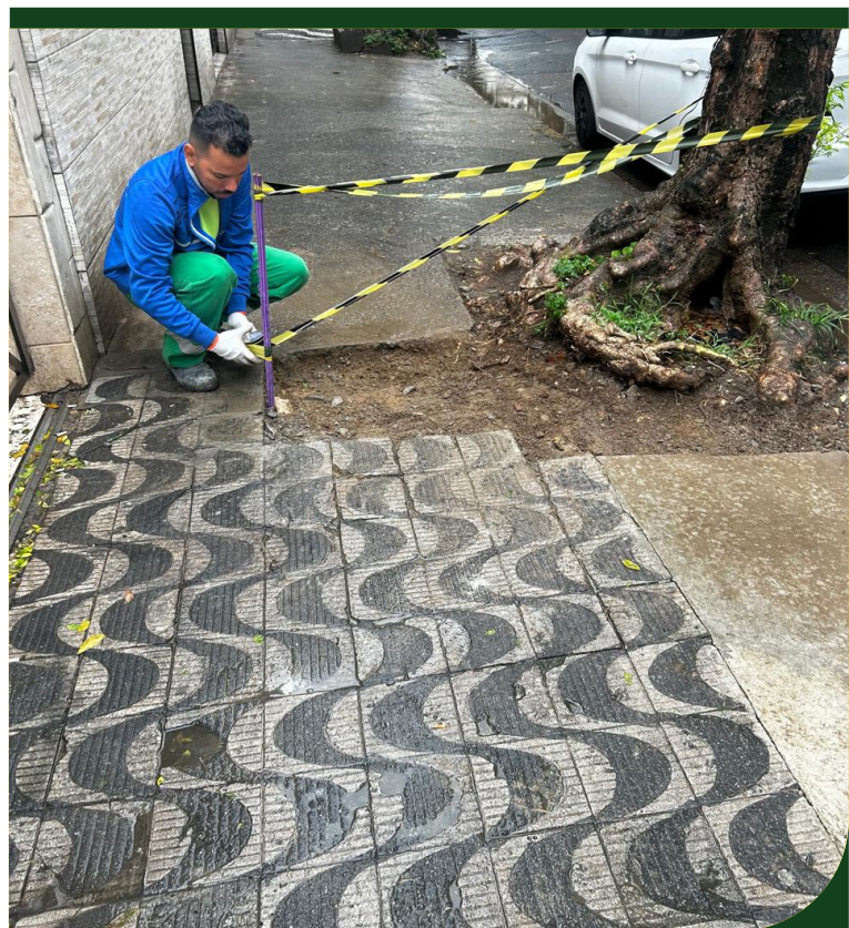
Reparo em calçada e abertura de berço na Rua Djalma Dutra, 1, Gonzaga
