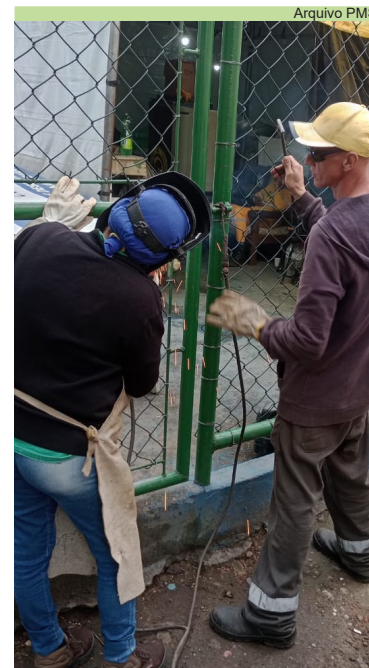
Soldagem de ferrolho, porta e cadeados na quadra do Última Ponte FC, na Vila Gilda
