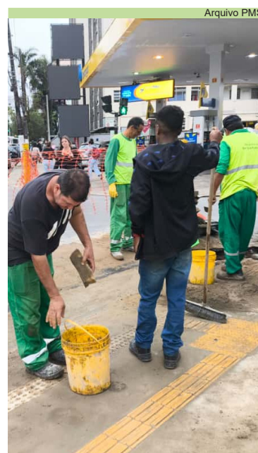
Colocação de tubulação e concretagem de sarjeta na esquina da Ana Costa com Luís de Faria
