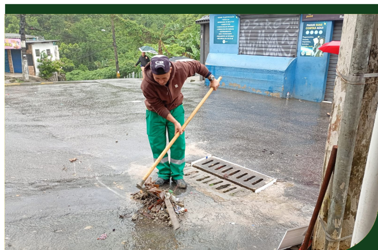
Troca de grelha na antiga Rua 1, em frente ao nº 1015, no Morro Santa Maria
