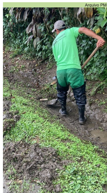
Limpeza de vala e caixa de drenagem na Rua Caramuru
