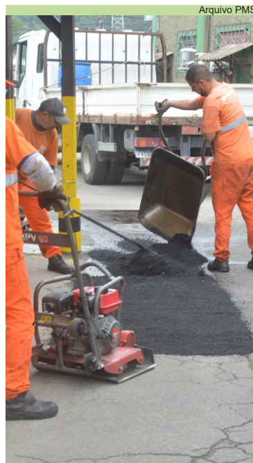
Serviço de recapeamento na sede da Prefeitura Regional da Zona Noroeste
