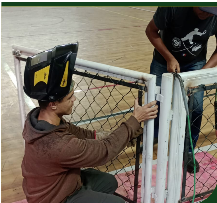
Término da soldagem de travessas e colocação de telas no alambrado da quadra esportiva do Ginásio Dale Coutinho, Castelo
