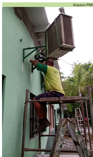
Adequação de ar condicionado para instalação de telhado na Prefeitura Regional
