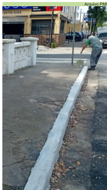
Pintura de muretas, guias e sarjetas na Avenida Siqueira Campos, Canal 4
