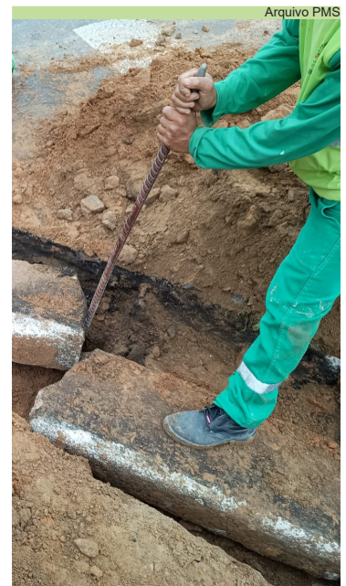
Construção de rampas de acessibilidade no bairro do Campo Grande
