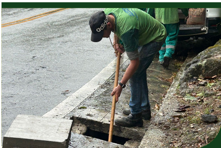
Manutenção asfáltica na Al. Pref. José Gomes, Morro da Cachoeira, Nova Cintra
