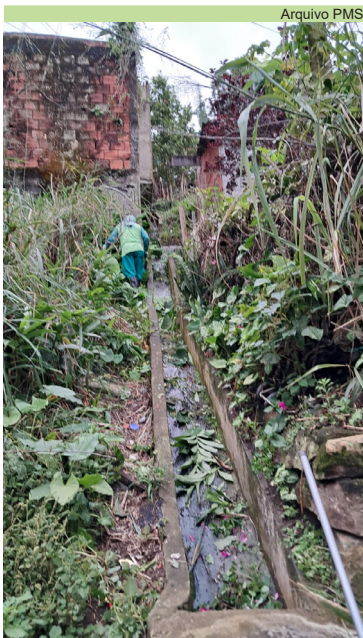
Limpeza de caixas e córrego na Rua 8, no Morro José Menino
