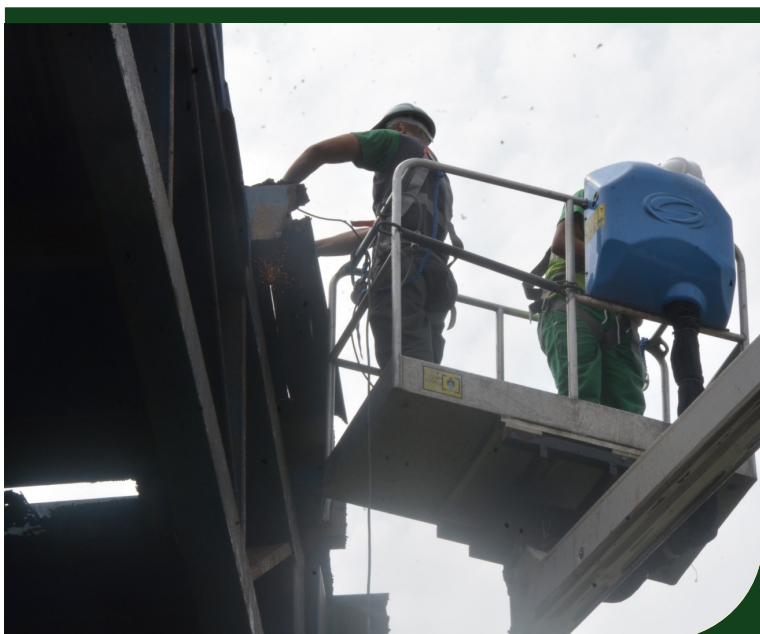
Troca das telhas da Quadra Poliesportiva da Praça da Paz Universal, no Castelo
