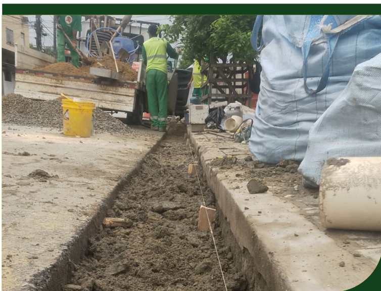
Continuação da ampliação de rede de drenagem na Rua Gastão Vidigal
