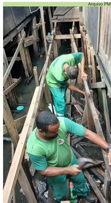
Manutenção da passarela do Caminho São Sebastião, em frente ao nº 161
