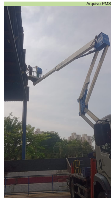
Colocação de parafusos nas telhas da quadra coberta na Praça da Paz Universal
