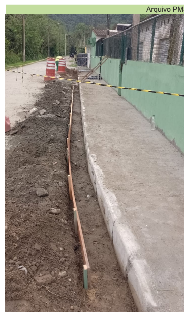
Instalação de sarrafos para a concretagem da sarjeta na SM do Caruara
