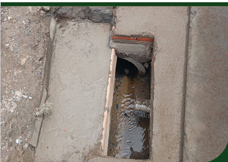
Manutenção de caixas de passagem na Sociedade de Melhoramentos do Caruara
