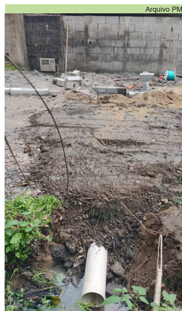
Instalação de tubos para drenagem de água pluvial na Rua Vila Rica
