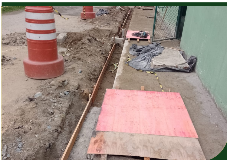
Colocação de sarrafos para concretagem da sarjeta na SM do Caruara
