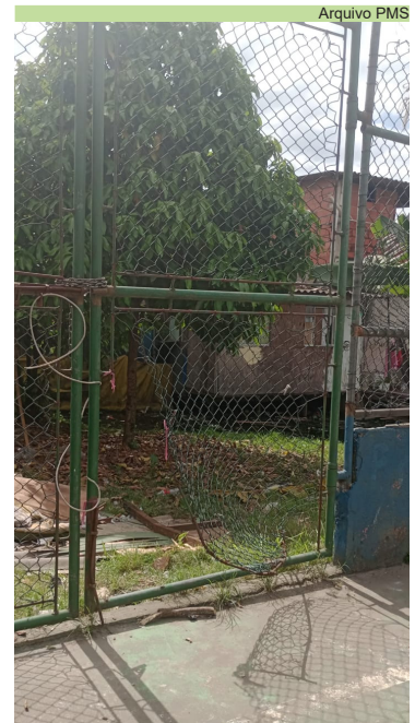
Vistoria na quadra esportiva do projeto contêiner na Travessa São Jorge, na Alemoa
