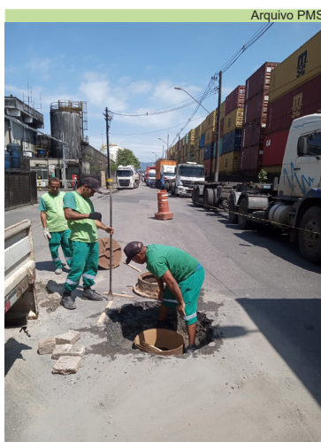
Substituição de poço de visita na Avenida Albert Schweitzer
