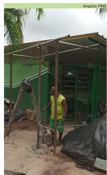
Instalação de tubos para alambrado e telhado na sede da Prefeitura Regional
