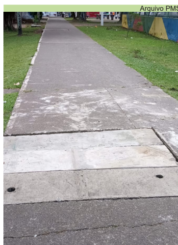
Substituição de tampas de concreto na Praça da Paz Universal
