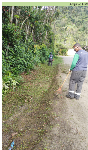
Serviço de roçada na Marginal Oeste, Rua Tupi e valão, no Caruara
