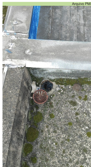
Vistoria para limpeza das calhas na sede do Posto Avançado de Zeladoria, Saboó
