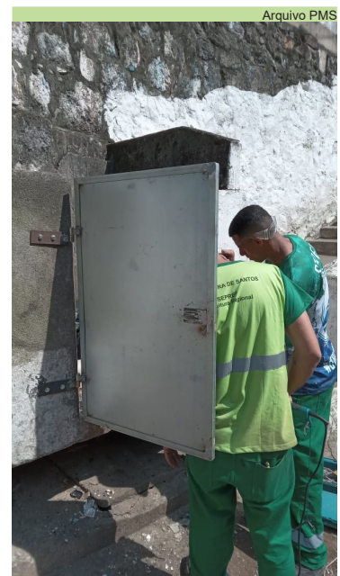
Produção de portão para a lixeira na Rua Nossa Senhora do Monte Serrat
