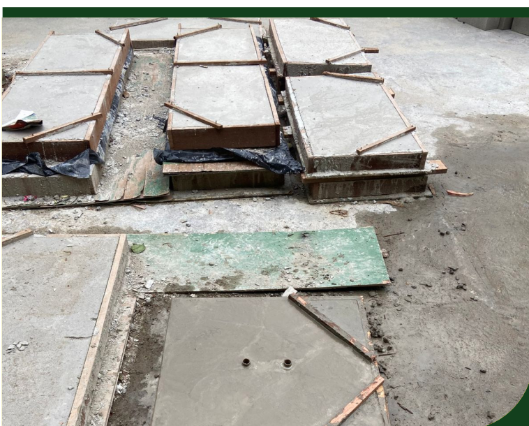
Produção de de tampa de concreto para caixa de esgoto para a sede da Prefeitura Regional da ZNO
