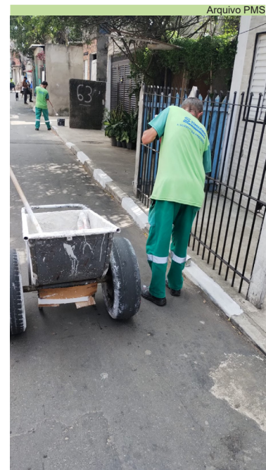
Pintura de postes e guias no Caminhão São Sebastião, do Beco 63 ao 163
