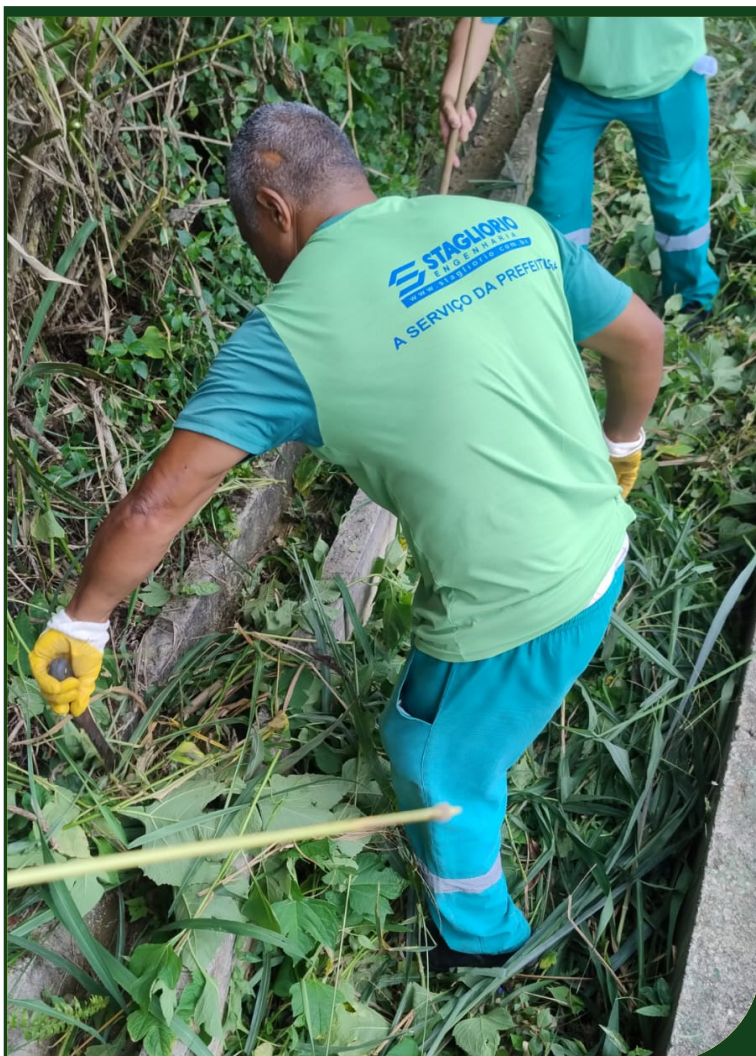
Limpeza de canaletas, canal e escada hidráulica na Avenida Antônio Manoel de Carvalho, no Morro Marapé
