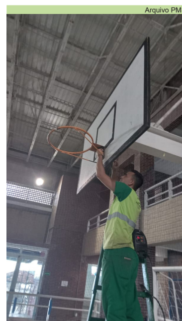
Conserto do aro e chapa da tabela na quadra da Vila Criativa, da Vila Progresso
