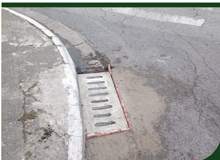
Substituição de bocas de lobo nas avenidas Brigadeiro Faria Lima, Hugo Maia e Rua Francisco de Domênico
