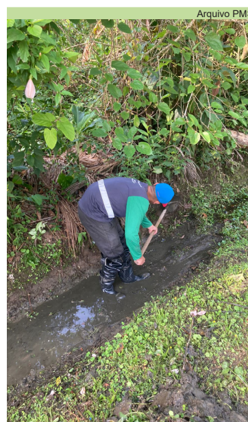
Serviço de limpeza de vala na Rua Xavantes, no Caruara
