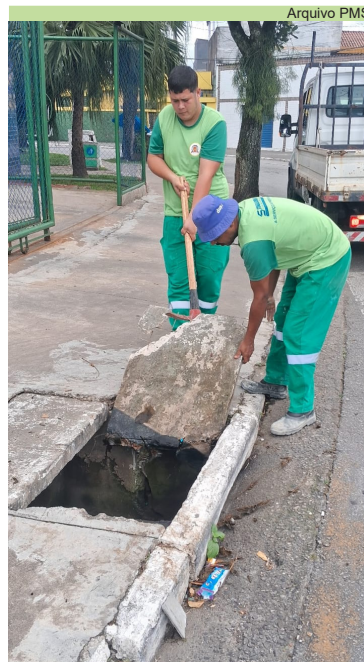
Substituição de tampas de concreto na Praça Jerônimo La Terza
