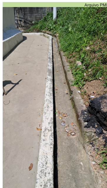
Limpeza de canaleta na Rua Santa Inez, no Morro São Bento
