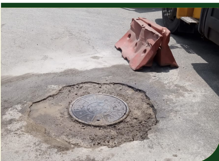
Substituição de poço de visita e boca de lobo na Rua Bóris Kauffmann, número 218, no Chico de Paula
