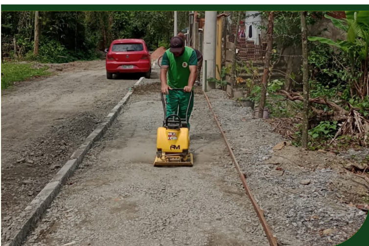
Compactação de solo para posterior concretagem de calçada na Rua Vila Rica
