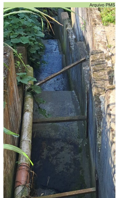
Limpeza de caixas e Hidráulica Av. Nossa Senhora do Monte Serrat
