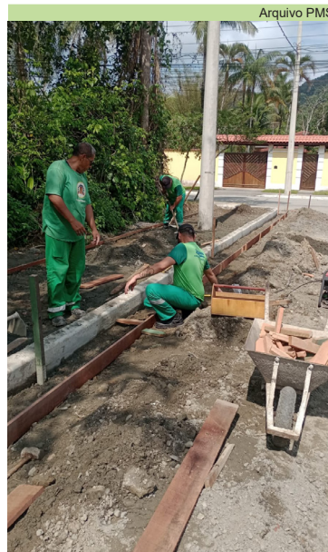
Instalação de sarrafos para a concretagem da sarjeta na Rua Vila Rica
