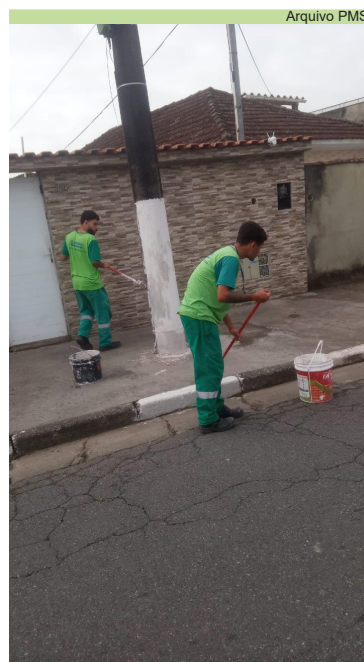
Pintura de postes e guias na Rua Tenente Durval do Amaral, no Rádio Clube
