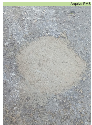
Manutenção asfáltica na Rua Santa Helena, em frente ao nº 170, no São Bento
