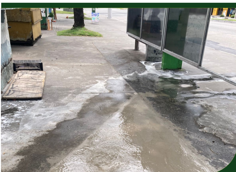
Reparo em calçada e substituição de tampas na Praça Ruth Fernandes Mafuz, na Areia Branca
