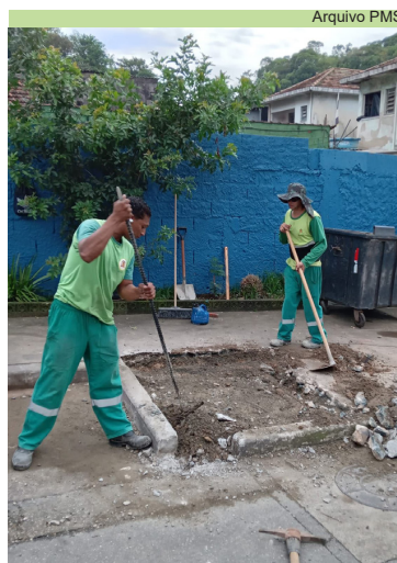
Construção de baia para colocação de contentor na Amália Rodrigues
