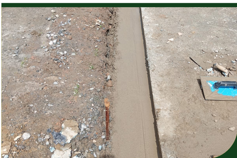
Reparos na calçada e sarjeta em frente à Sociedade de melhoramentos do Caruara
