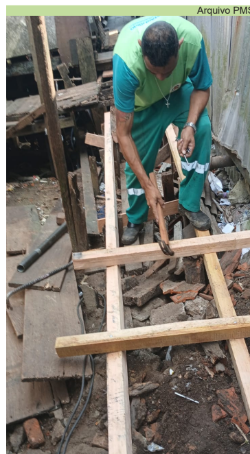
Manutenção da passarela do Caminho São Sebastião, no Rádio Clube
