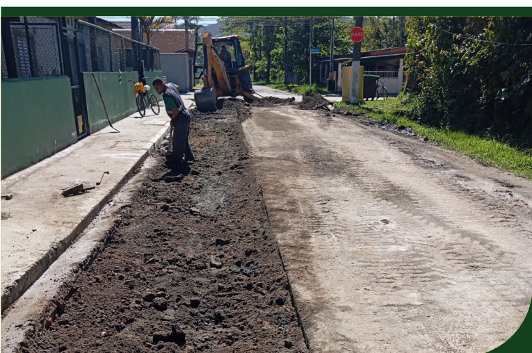
Retirada de asfalto e nivelamento de rua em frente à SM do Caruara
