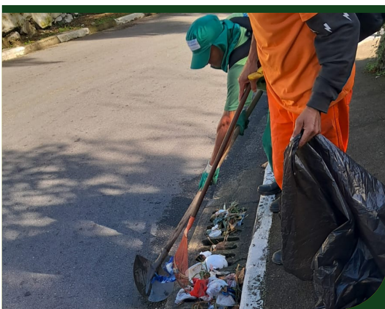
Limpeza de caixas e córrego na Avenida Nossa Sra do Monte Serrat, no São Bento
