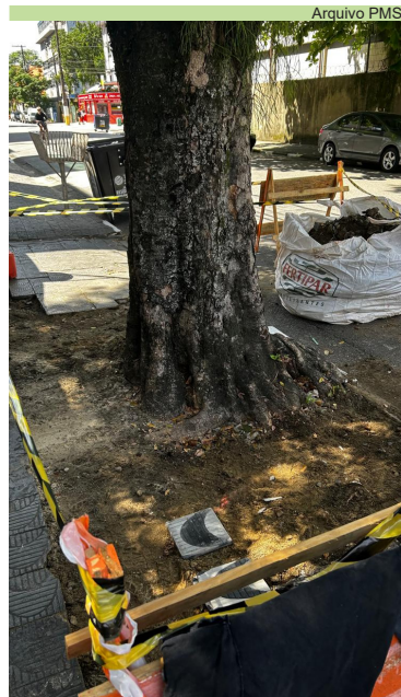
Reparo em calçada e abertura de berço na Rua Henrique Soler, na Ponta da Praia
