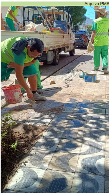
Reparo em piso copacabana na Avenida Coronel Joaquim Montenegro, na Aparecida
