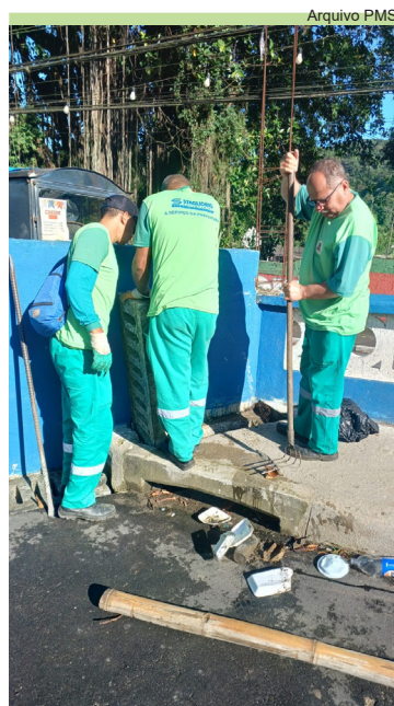
Limpeza de grelhas ao lado da Escola de Samba Unidos dos Morros, no Nova Cintra
