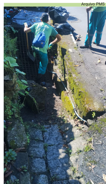
Limpeza de caixas e escada hidráulica Nicho 3, no Monte Serrat
