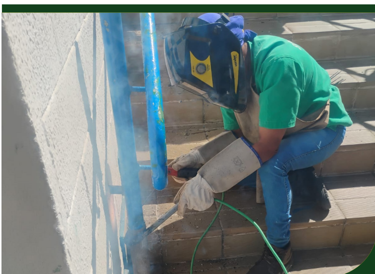
Soldagem dos corrimãos de acesso à piscina do Centro Esportivo Dale Coutinho, no Castelo
