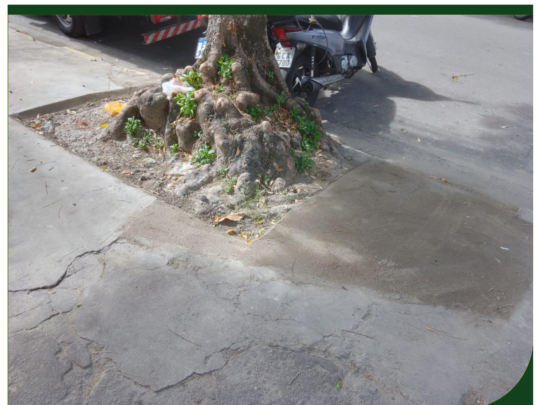
Abertura de berço e reparo em calçada na Rua Barão de Paranapiacaba, em frente ao número 18, na Encruzilhada
