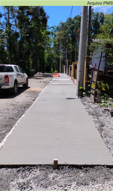
Concretagem de calçada na Rua Vila Rica, no Caruara
