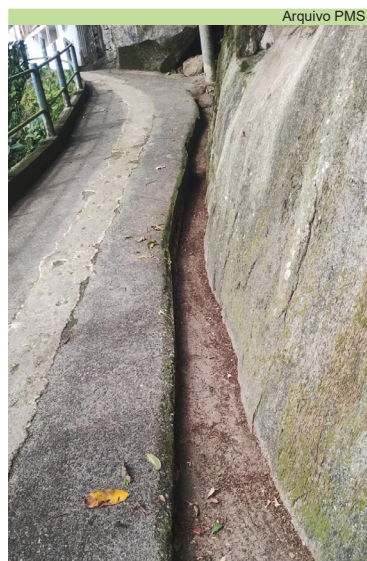
Limpeza de canaleta na Rua José Lessa Luiz, Morro Jabaquara
