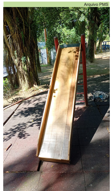
Instalação de prancha de escorregador na Lagoa da Saudade, Nova Cintra
