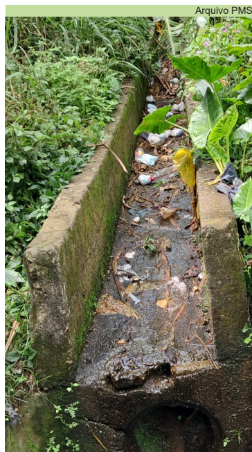
Serviço de limpeza de canal e caixas na Rua Santa Marta, no Morro São Bento
