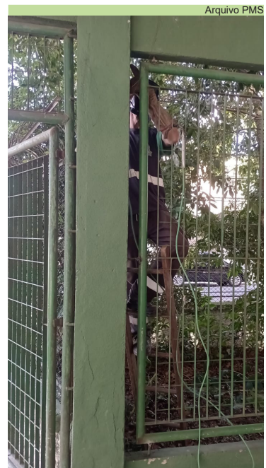
Soldagem de gradil no Cecon, do Centro Esportivo M. Nascimento Jr.
