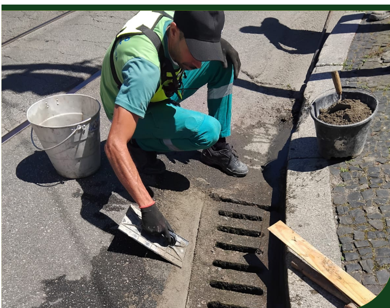
Reparo em boca de lobo na confluência entre a São Francisco e a Braz Cubas
