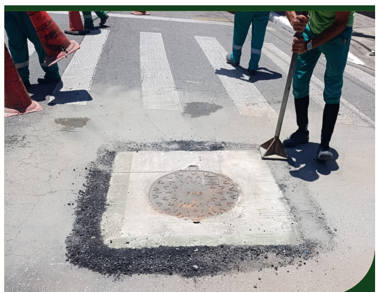
Troca de poço de visita com laje no trecho Senador Feijó x Bitencourt
