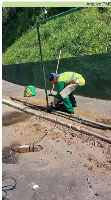
Retirada de tubos galvanizados ociosos na Rua 10, no Santa Maria
