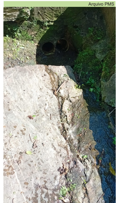
Limpeza de caixas e córrego Marina Magalhães, no Morro São Bento
