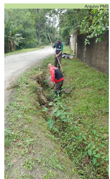
Serviço de limpeza de vala da Rua Tupi, no Caruara
