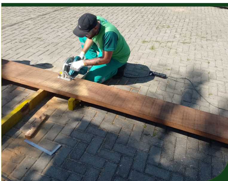
Continuação dos trabalhos de manutenção do píer da Ilha Diana
