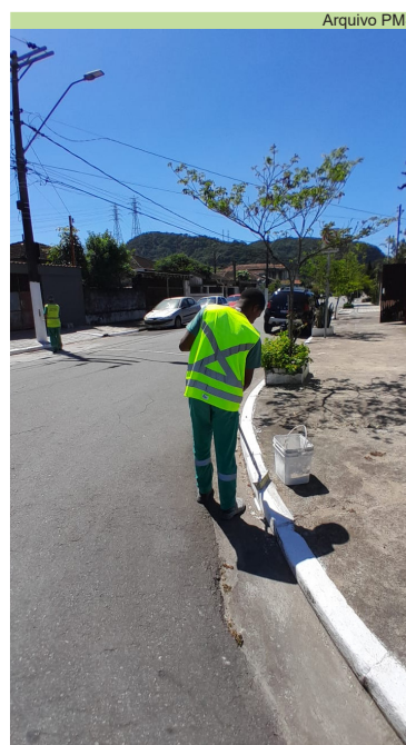
Pintura de guias e postes na Rua Amadeo Barbiellini, no Santa Maria
