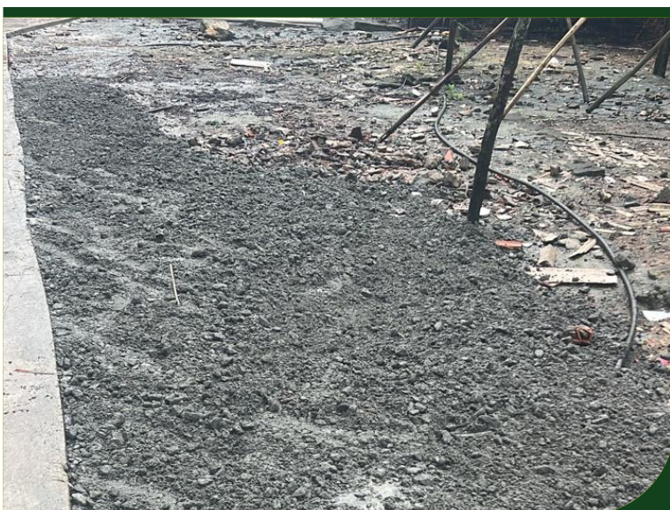
Limpeza e aplicação de bica corrida no Caminho Manoel Ferretti, no Monte Cabrão
