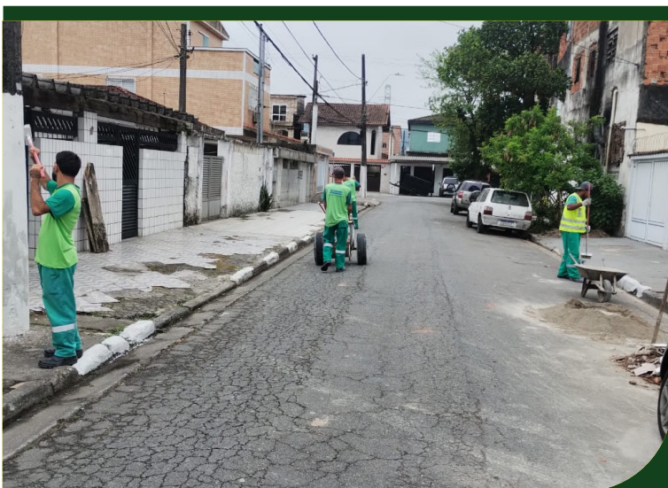
Pintura de guias e postes nas ruas Sancho B. P. Sobrinho e Arthur Alves Firmino, no Rádio Clube
