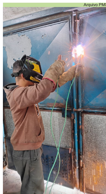
Soldagem de portão no antigo prédio da UME Waldery de Almeida
