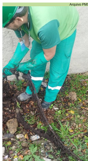
Limpeza de caixa de passagem na UME Pedro Crescenti, no Rádio Clube
