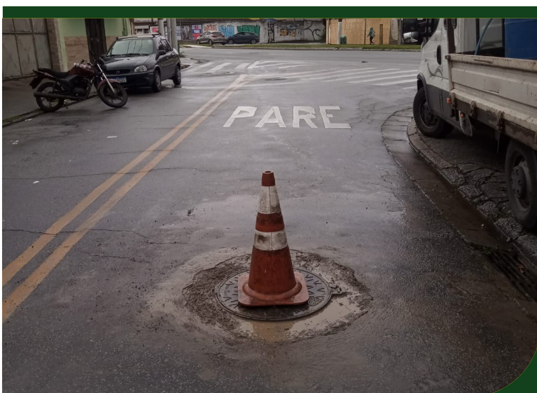
Substituição de poço de visita na Rua Álvaro Pinto da Silva Novaes Filho, em frente ao número 44, Caneleira
