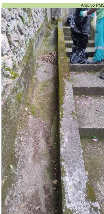
Limpeza de grelhas e canaleta na Rua São Felipe
