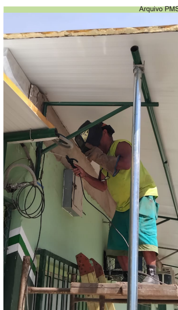
Reforço na estrutura do telhado da Prefeitura Regional
