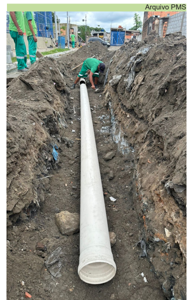
Continuação de instalação de ramal de drenagem na Comunidade 52
