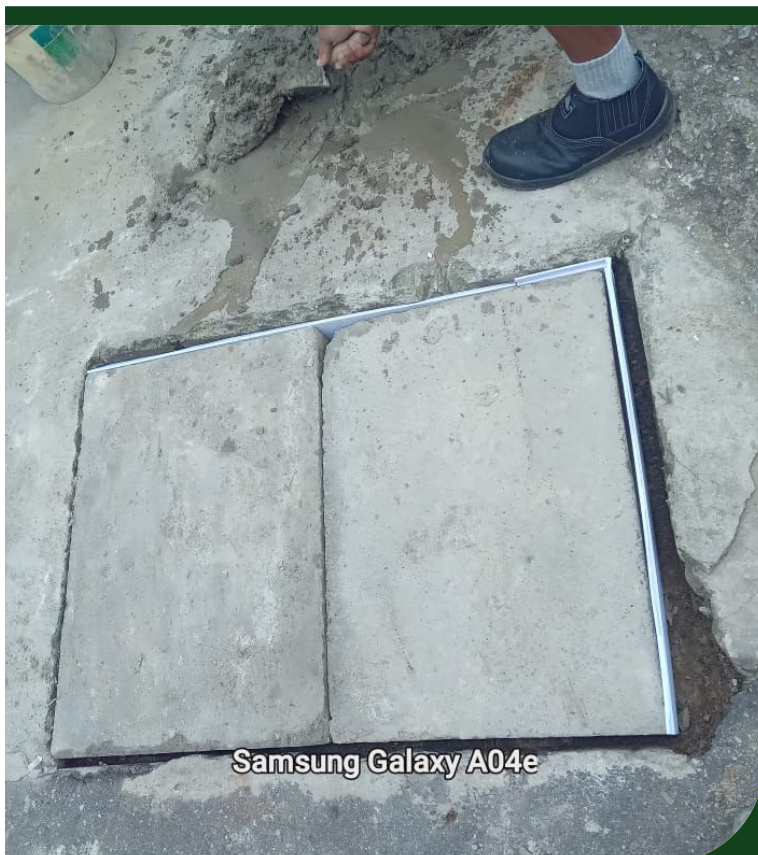
Troca de tampas de concreto na antiga Rua 1, próximo padaria da Nelma, Morro Santa Maria
