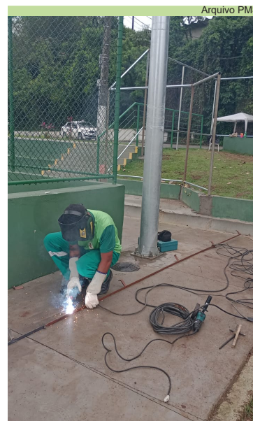
Instalação de trilho para o portão no Campo da Caneleira, no Morro Jabaquara
