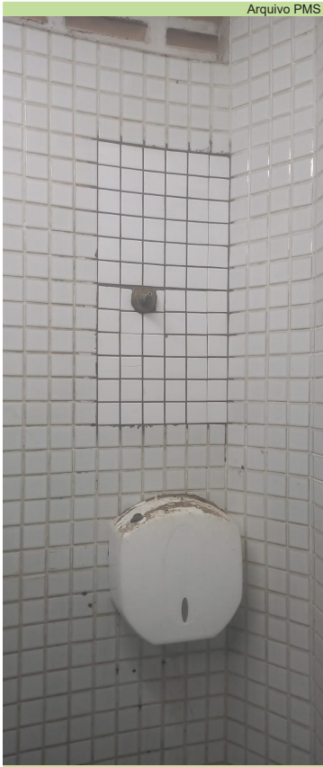
Reposição de pastilhas do banheiro masculino, no Canal 1
