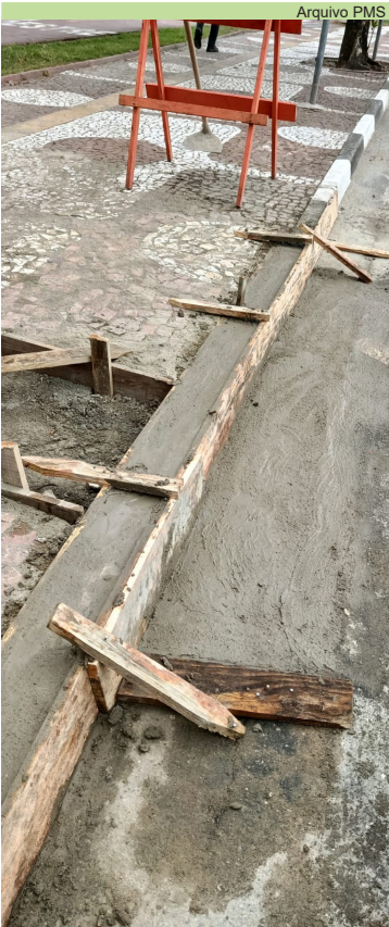
Construção de meio-fio e sarjeta na Av. Bartolomeu de Gusmão
