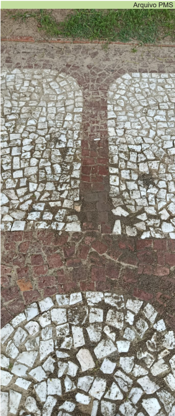
Reparo no piso mosaico no calçadão da orla, no chuveirinho 9
