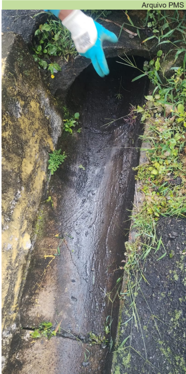
Serviço de limpeza de canaleta Rua 2 Vila Progresso
