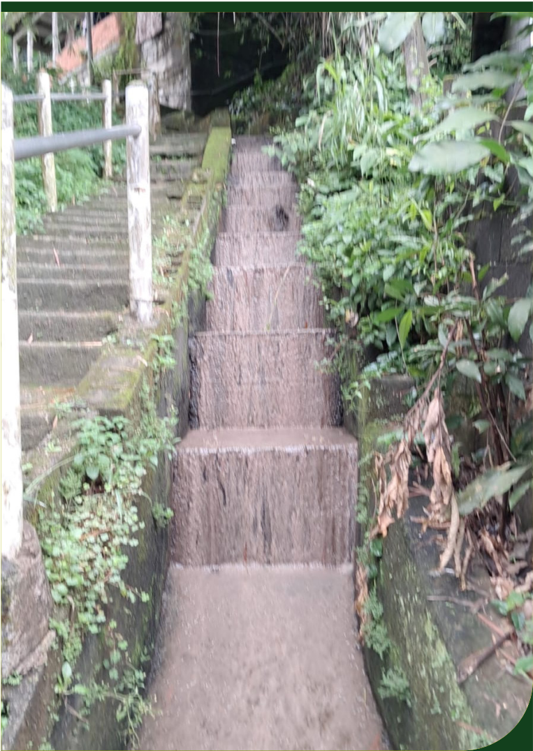
Limpeza de caixas e escada hidráulica no Caminho dos Trinta, no Morro Saboó
