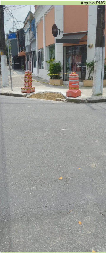
Instalação de rampa de acessibilidade no Macuco
