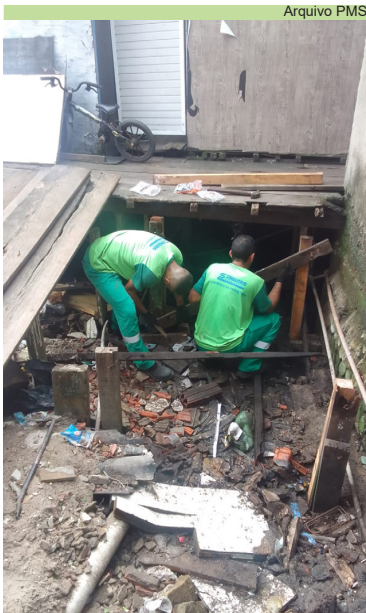
Manutenção da passarela do Caminho São Sebastião, no Rádio Clube
