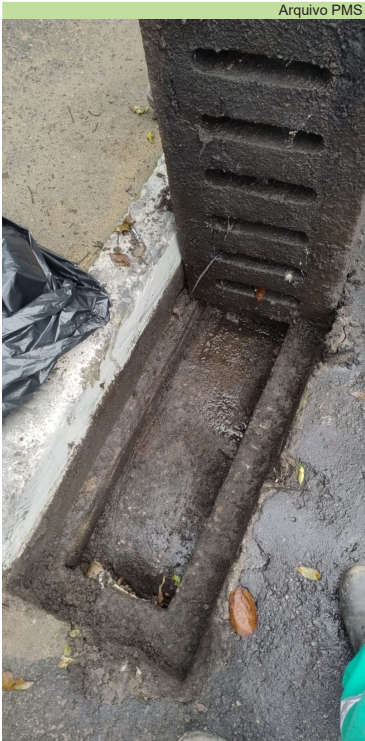
Limpeza de grelhas na Rua 3, na Vila Progresso
