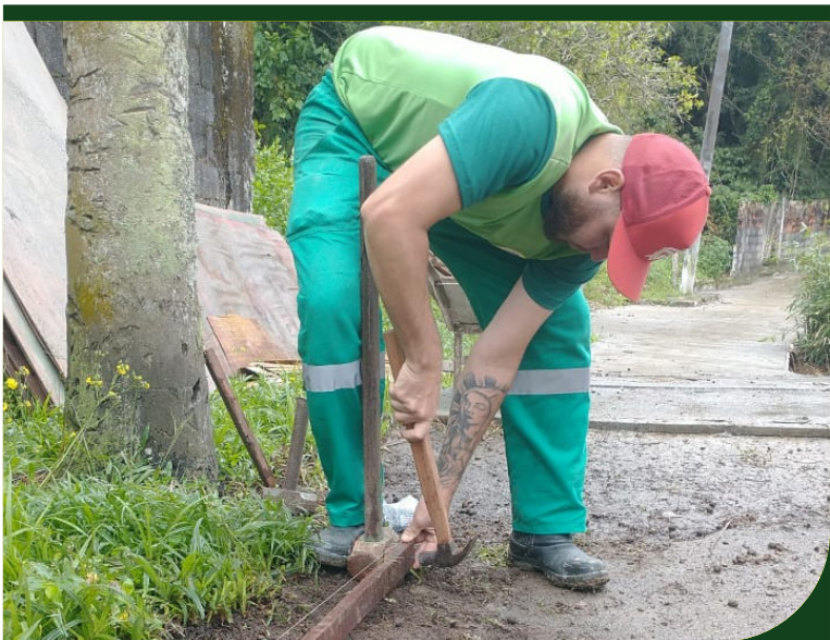
Instalação de sarrafos para concretagem do caminho Manoel Ferretti, no Monte Cabrão
