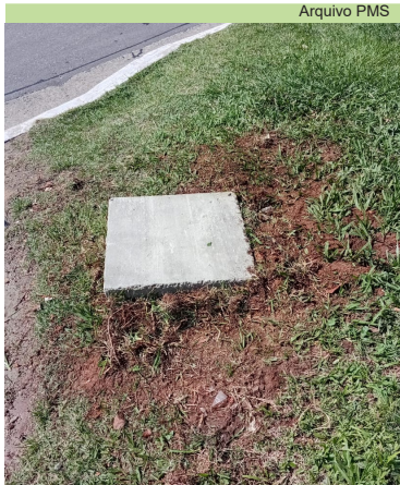
Troca de tampa de concreto no canteiro central, na Pres. Wilson
