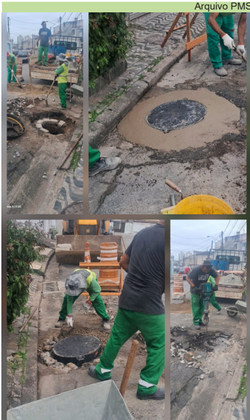
Troca e nivelamento de poço de visita na Rua Walter Belian, na Areia Branca
